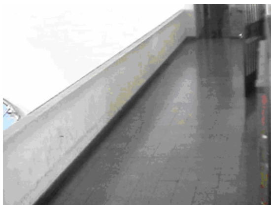
Fig. 8.59 Instalación final de la Cámara y vista del área principal con la cámara con una lente de 8 mm.
