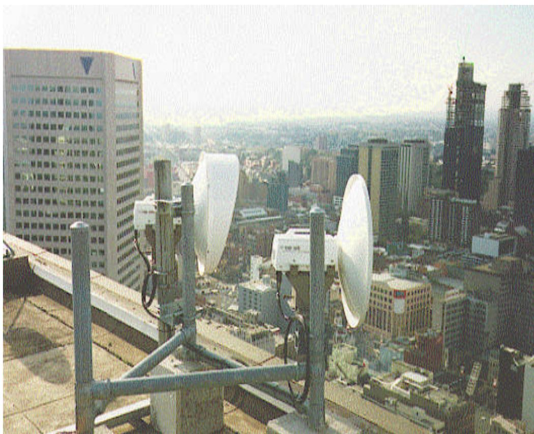
Figura 5.4. Típica radio todo externo (outdoor).
