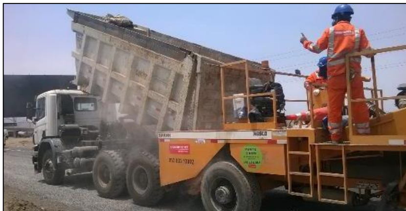
Figura N° 2.2. Camión tolva en proceso de descarga de asfalto – proceso de pavimentación.
