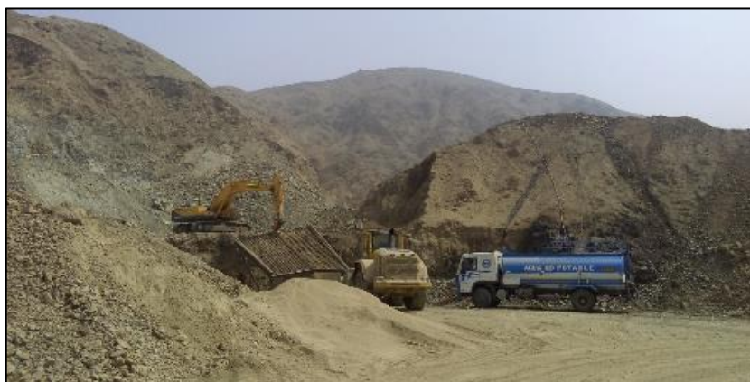
Figura N° 2.4. Camión cisterna realizando el riego de vías en la cantera de extracción de material de relleno.
