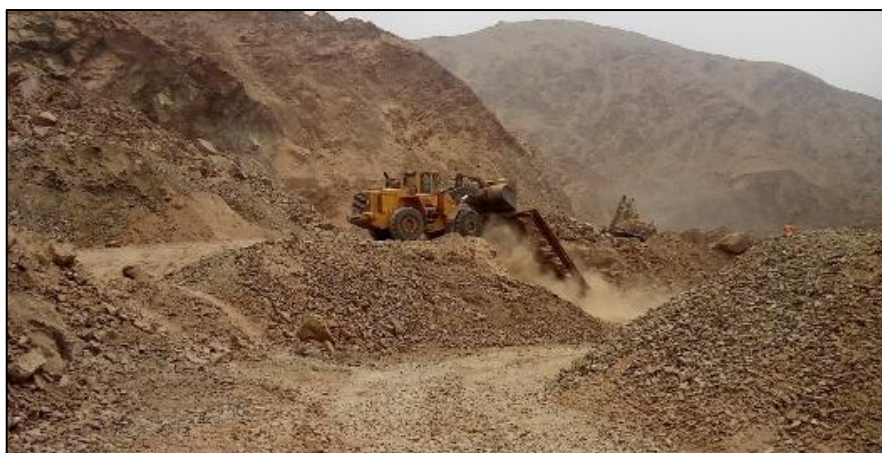
Figura N° 2.15. Explotación de la cantera Michelot – distrito de Cajamarquilla.
