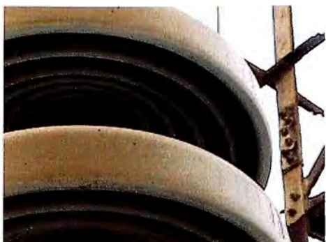
Foto. 8: Insulator # A125-4 – in the wind Aislador cadena A125-4 vista al viento
