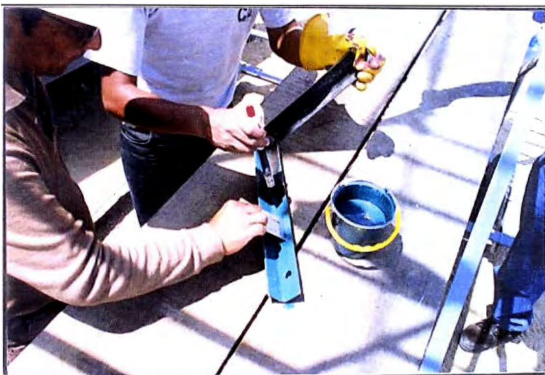
Foto N° 13: Sistema N° 5 Control de Espesor en Humedo
