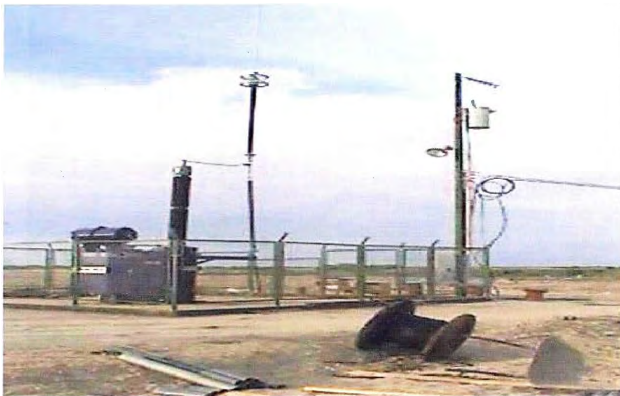
Foto N° 1: Sección de Alimentación por un transformador monofasico 200 KVA, 127 /0.24/0.12 kV, vía un fusible. También se muestra el transformador de 14.4KV/220V .
