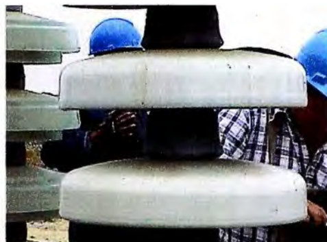
Foto 8A : Insulator # B125-4, lee side Aislador cadena A125-4 opuesto al viento
