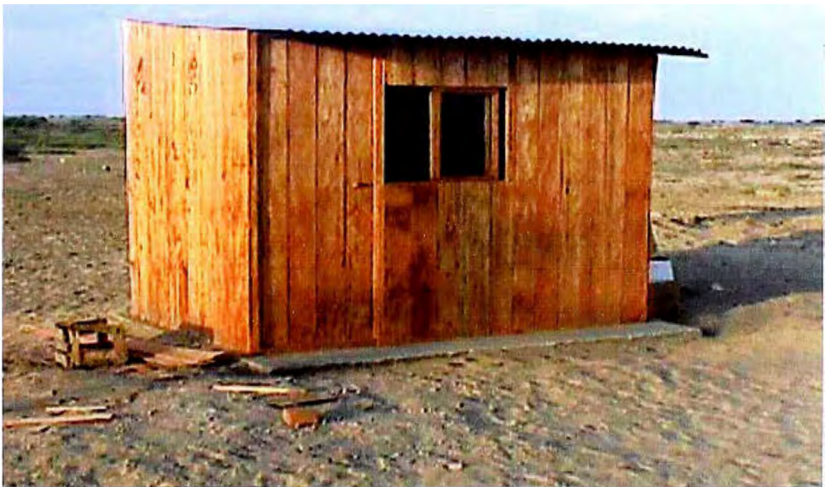
Foto N° 6: Vista de la caseta de vigilancia.
