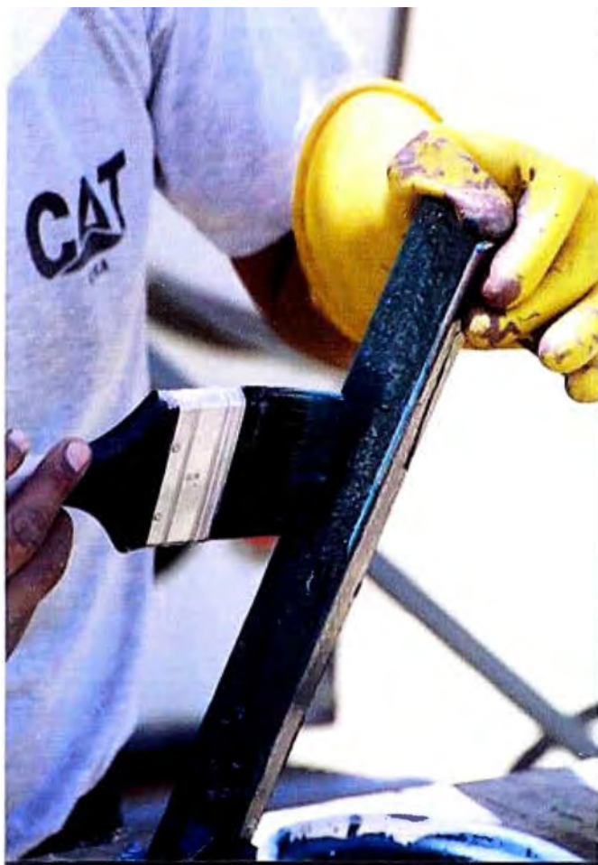
Foto N° 12: Sistema N° 5 Aplicación de la 1ra capa zinc E-303 EPOXICO
