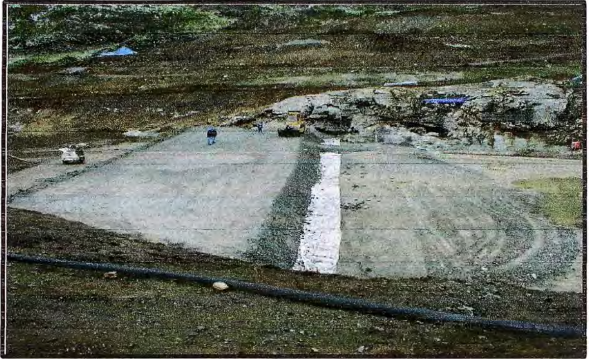
FOTO N° 41 OBRAS DE LA PRESA DEL RESERVORIO.
