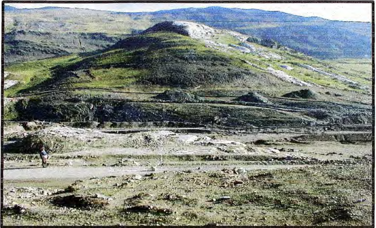
FOTO N° 35 PANORÁMICA ZONA DE PRESA DEL RESERVORIO Y OBRAS DE TOMA CANAL DE DERIVACIÓN. (AL N)
