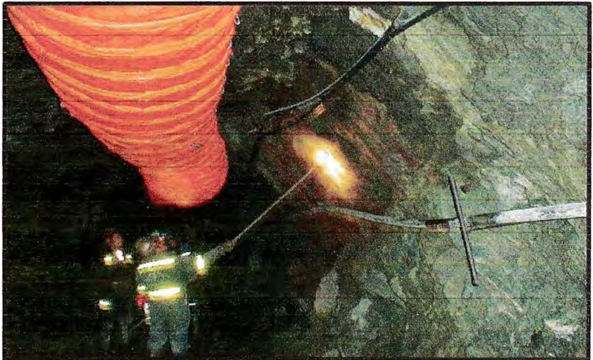
FOTO N° 22 MARCADO DEL SOSTENIMIENTO TÚNEL DEFINITIVO.
