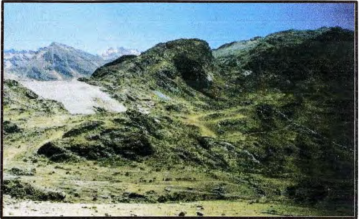
FOTO N° 5 : PRESA DE RELAVES ANDAYCHAGUA ZONA DE PIE DE PRESA. (AL NW)
