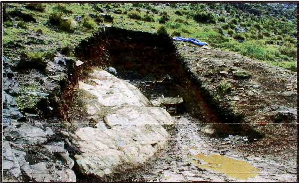
FOTO N° 20 INICIO DE EXCAVACIÓN DEL TÚNEL DEFINITIVO.
