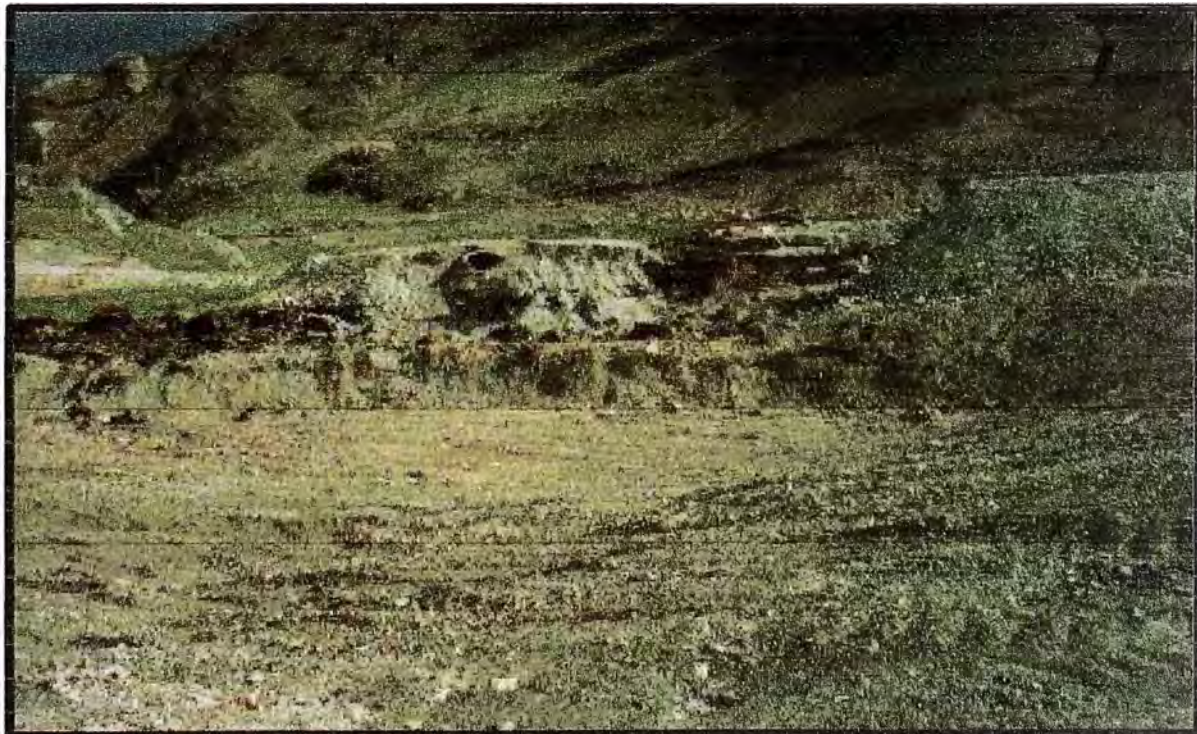
FOTO N° 4 : ZONA DE COLAPSO NUEVA PRESA DE RELAVES ANDAYCHAGUA DURANTE EL PROCESO DE LIMPIEZA.
