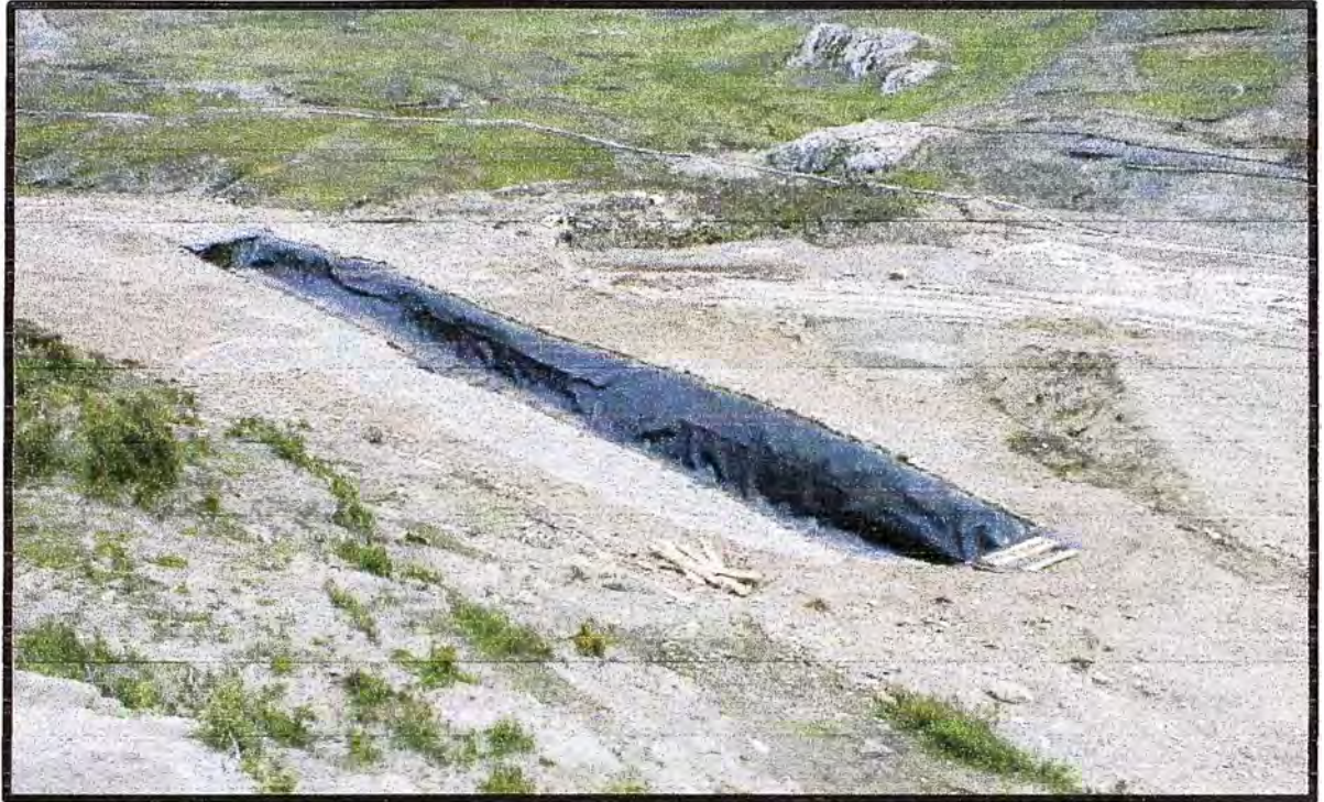
FOTO N° 37 INSTALACIÓN DE DREN EN LA PRESA DEL RESERVORIO.
