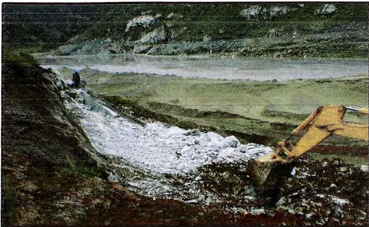
FOTO N° 29 TRABAJOS DE EXCAVACIÓN DEL CANAL DE DERIVACIÓN.
