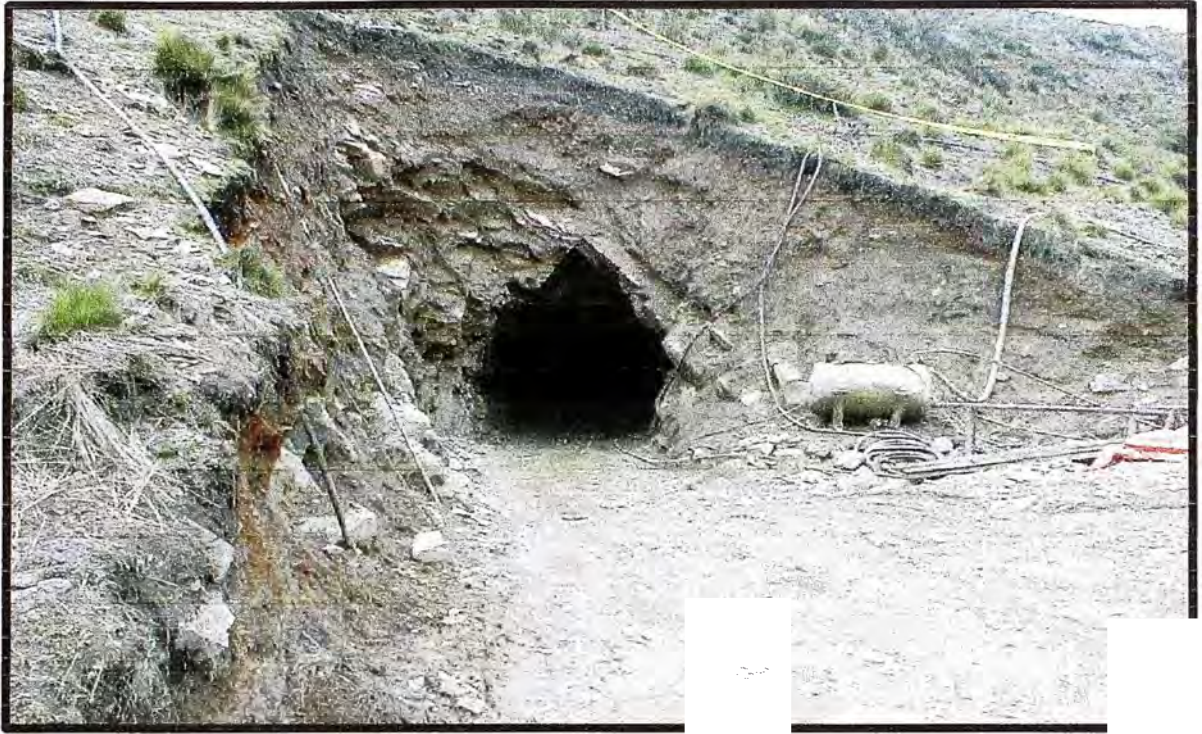
FOTO N° 21 PORTAL DE ENTRADA TÚNEL DEFINITIVO.
