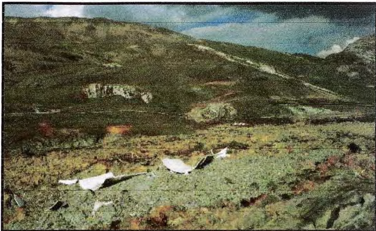
FOTO N° 3 : ZONA DE COLAPSO NUEVA PRESA DE RELAVES ANDAYCHAGUA. (AL NE)
