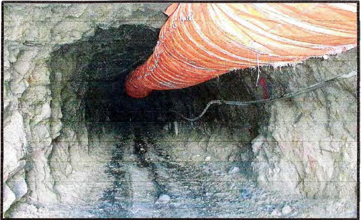
FOTO N° 23 VISTA INTERIOR DURANTE LA EJECUCIÓN DEL TÚNEL DEFINITIVO.
