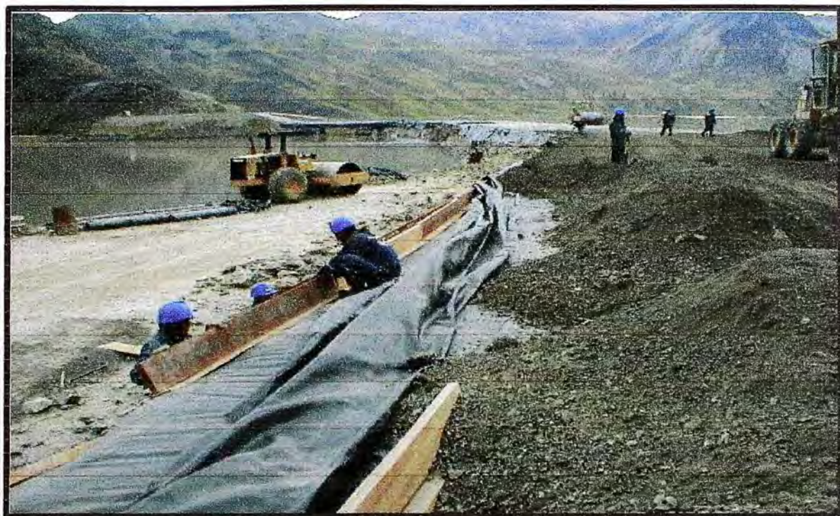
FOTO N° 15 : DETALLE OBRAS DE RECRECIMIENTO Y REFORZAMIENTO PRESA DE RELAVES DE ANDAYCHAGUA. COLOCACIÓN DE RELLENO CON GEOTEXTIL.
