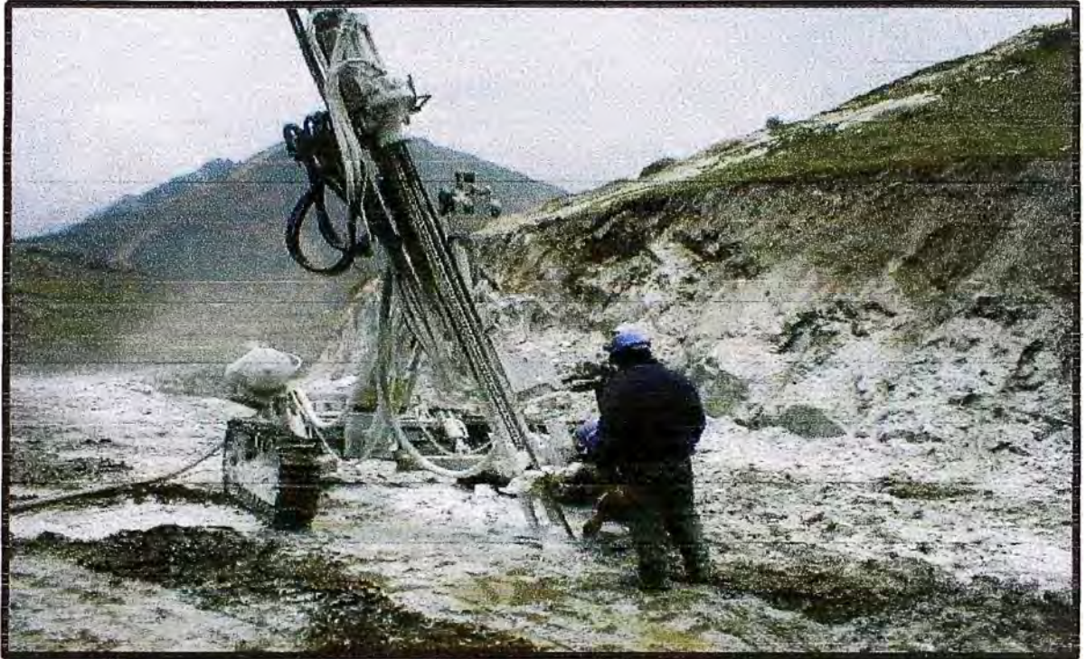
FOTO N° 31 TRABAJOS DE PERFORACIÓN EN ROCA, DEL CANAL DE DERIVACIÓN.
