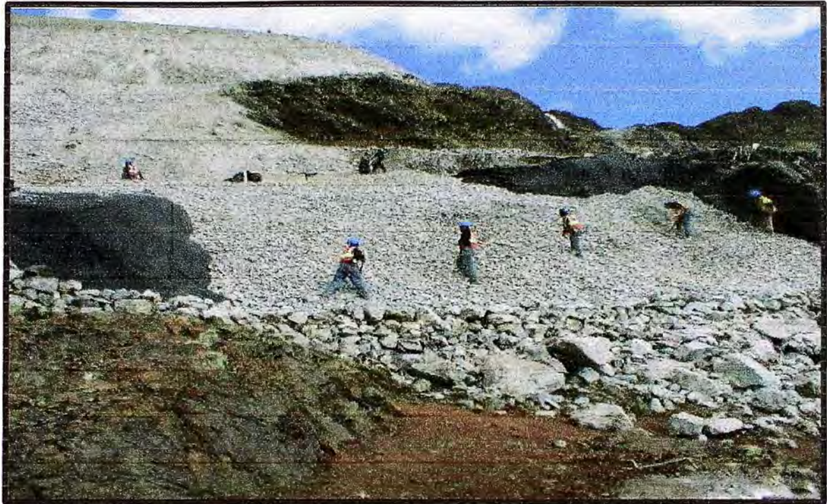
FOTO N° 17 DETALLE OBRAS DE RECRECIMIENTO Y REFORZAMIENTO PRESA DE RELAVES DE ANDAYCHAGUA – ACOMODO DE GRAVA.
