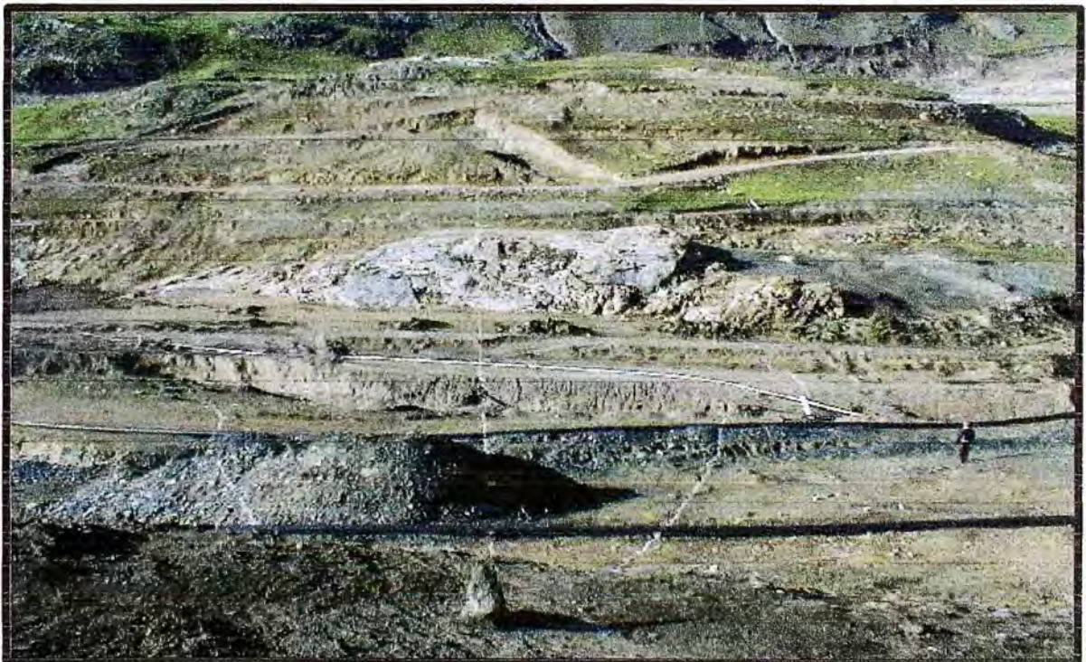
FOTO N° 36 PANORÁMICA ZONA DE PRESA DEL RESERVORIO Y OBRAS DE TOMA CANAL DE DERIVACIÓN. (AL S)
