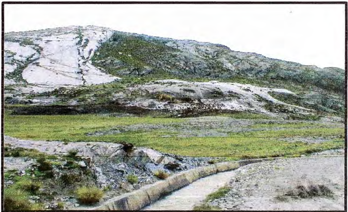
FOTO N° 26 : TRABAJOS DE EXCAVACIÓN CANAL DE DERIVACIÓN. NÓTESE EL CANAL DE DERIVACIÓN ANTIGUO EN LA PARTE INFERIOR CENTRAL DE LA FOTO.
