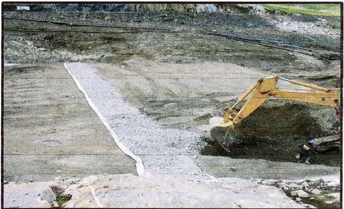
FOTO N° 38 OBRAS DE PRESA DEL RESERVORIO.
