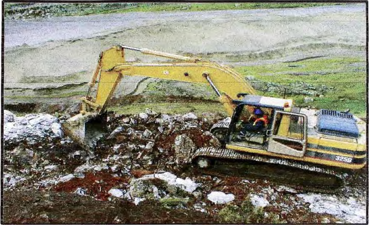
FOTO N° 33 TRABAJOS DE EXCAVACIÓN DEL CANAL DE DERIVACIÓN.
