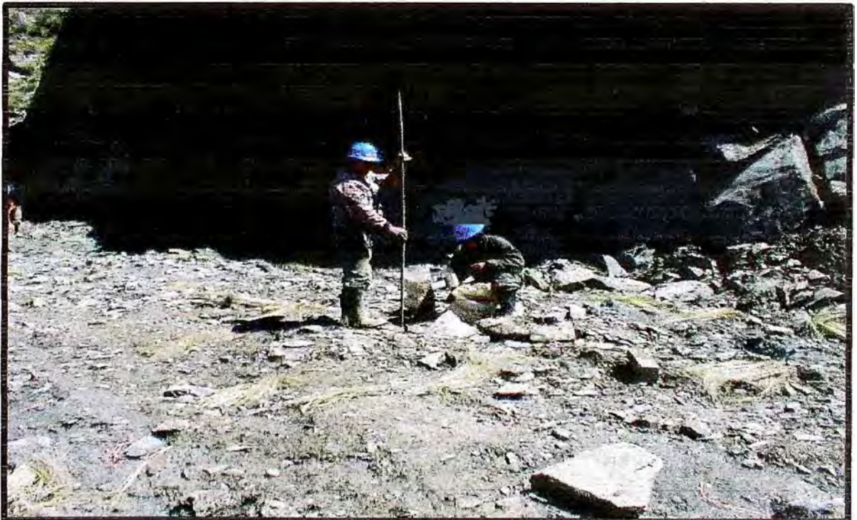
FOTO N° 32 CARGUIO DE TALADROS DEL CANAL DE DERIVACIÓN.
