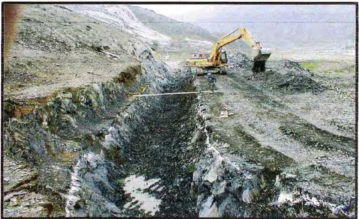
FOTO N° 34: VISTA PANORÁMICA DEL CANAL DE DERIVACIÓN.
