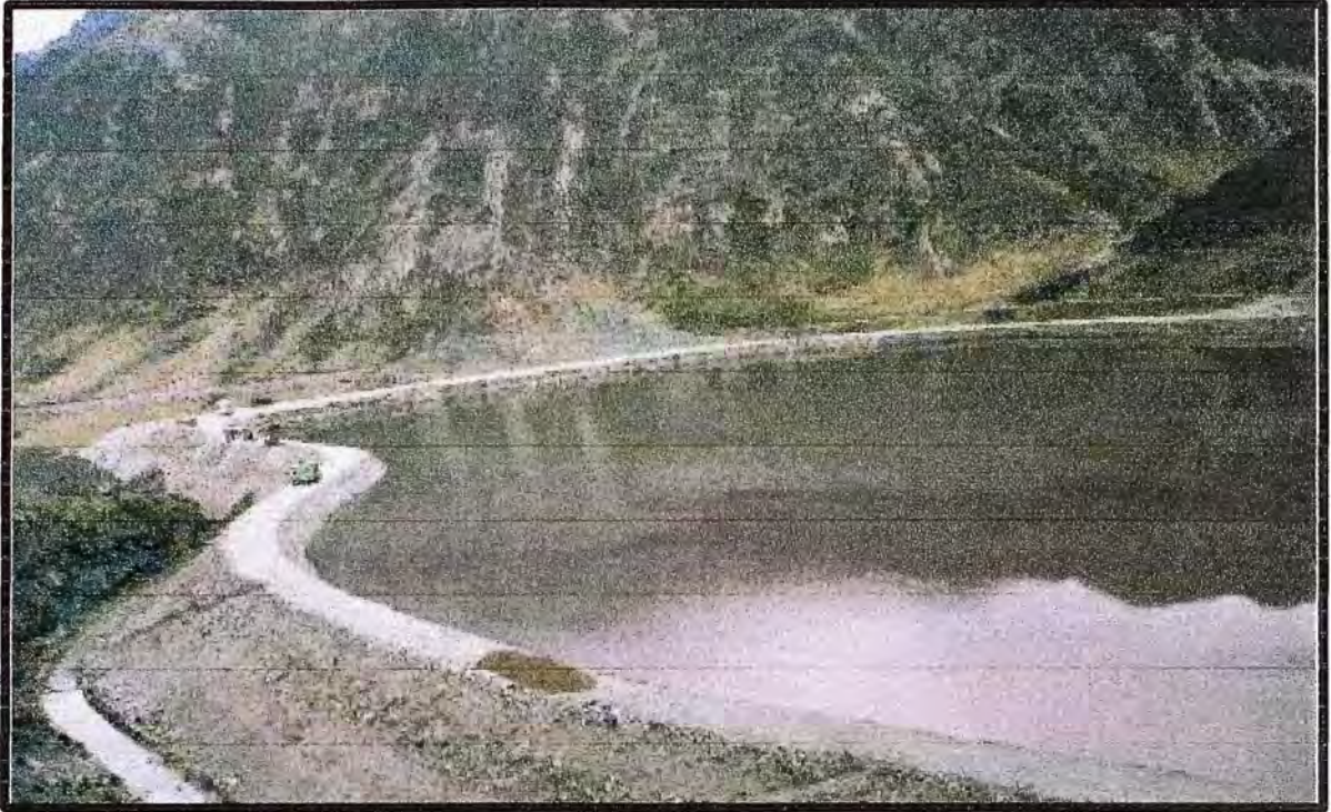
FOTO N° 7 : VISTA PANORÁMICA DE LA PRESA DE RELAVES, NÓTESE EN LA PARTE INFERIOR IZQUIERDA EL CANAL DE DERIVACIÓN EXISTENTE.
