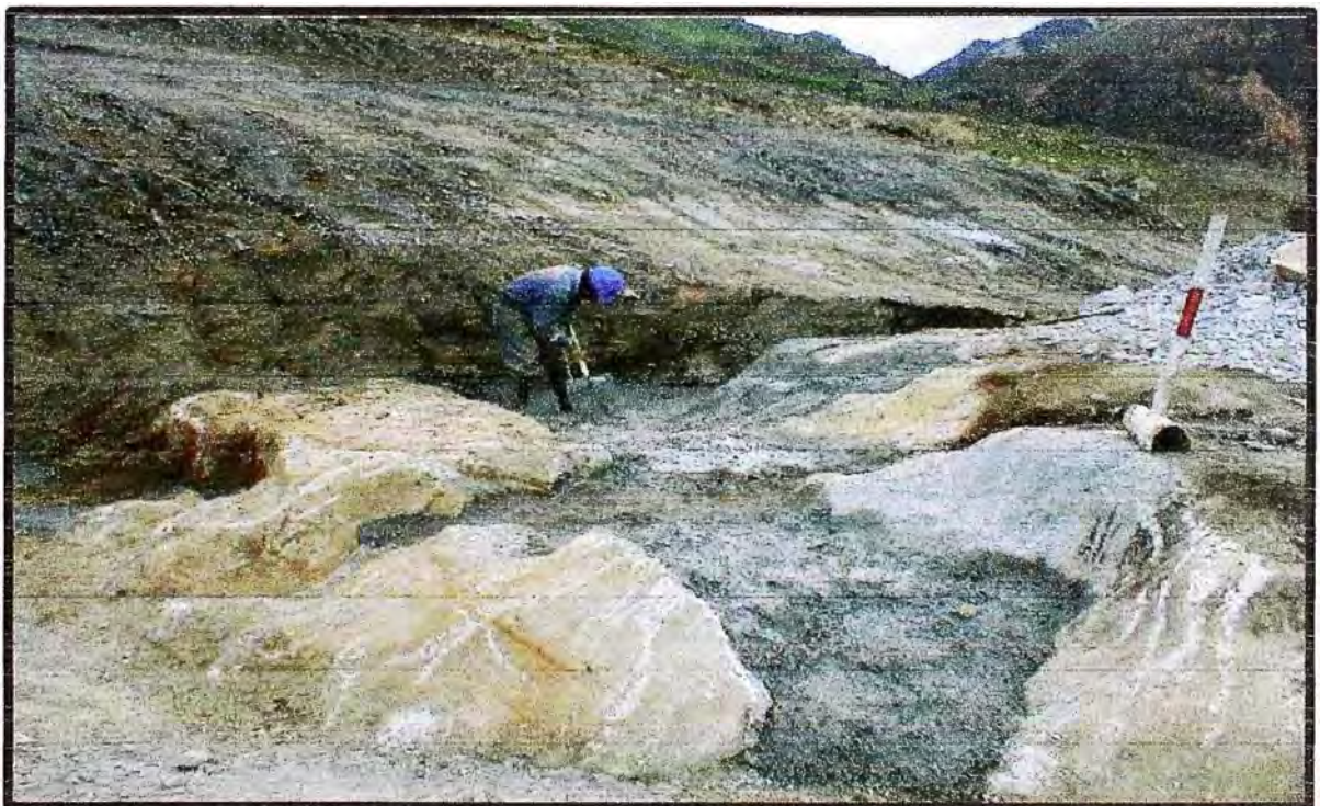
FOTO N° 40 : SELLADO DE FRACTURAS EN LA ZONA DE LA PRESA DEL RESERVORIO.
