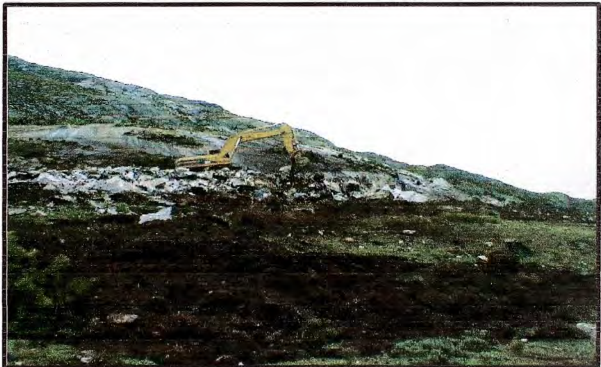
FOTO N° 28 TRABAJOS DE EXCAVACIÓN DEL CANAL DE DERIVACIÓN.
