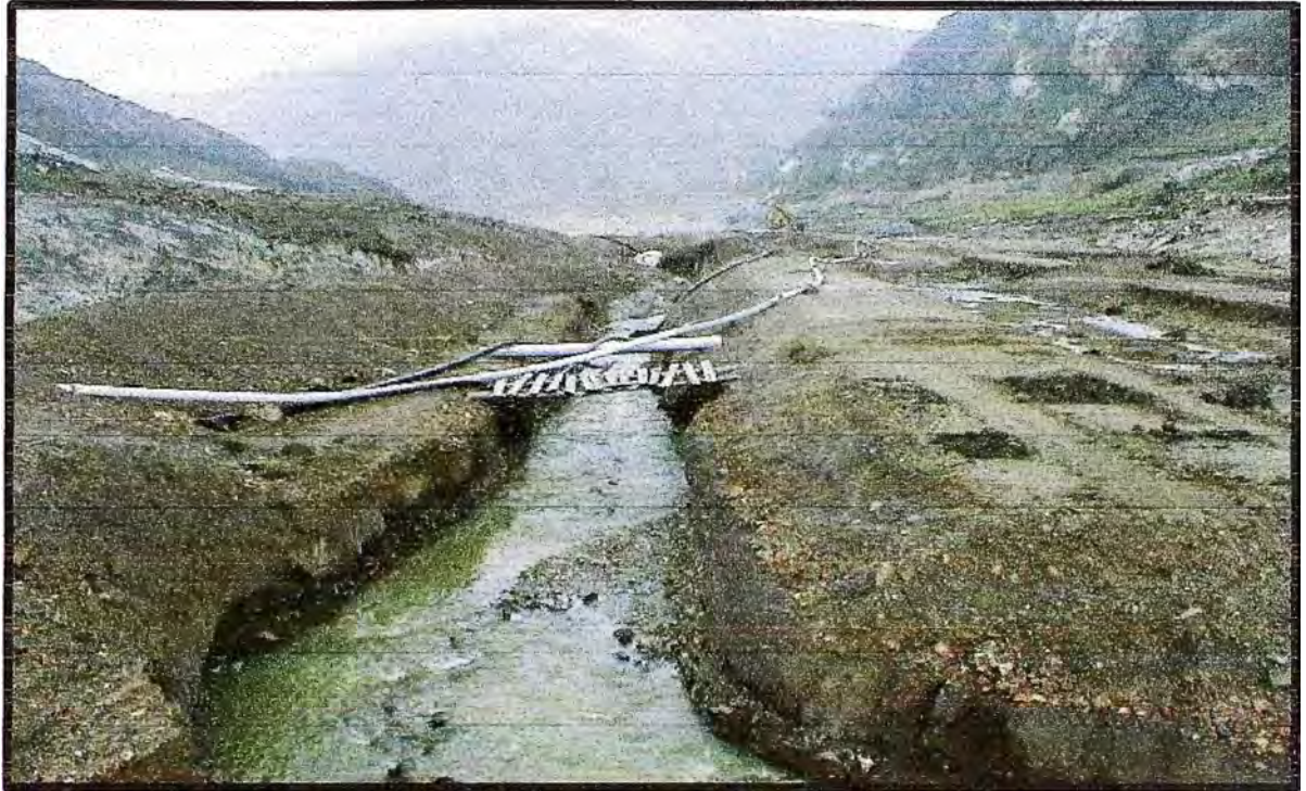
FOTO N° 39 : OBRAS DE DERIVACIÓN TEMPORAL, ZONA DE PRESA DE RESERVORIO.
