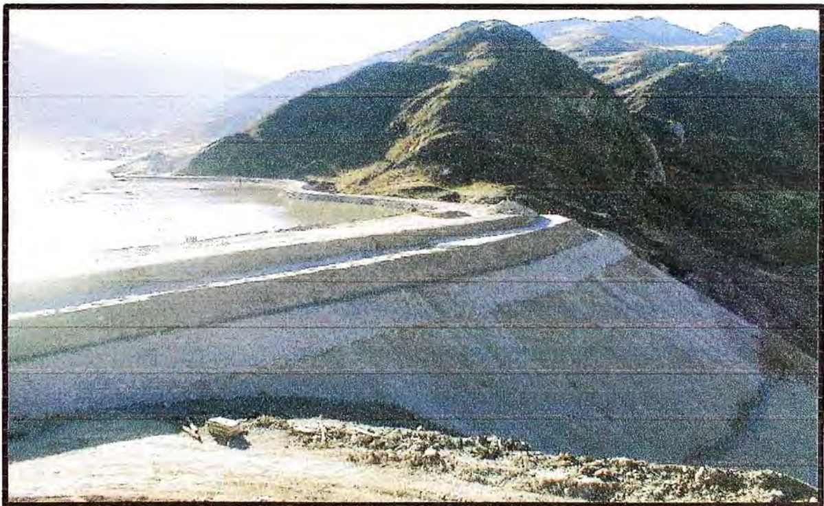
FOTO N° 18 PANORÁMICA RECRECIMIENTO Y REFORZAMIENTO PRESA DE RELAVES DE ANDAYCHAGUA.
