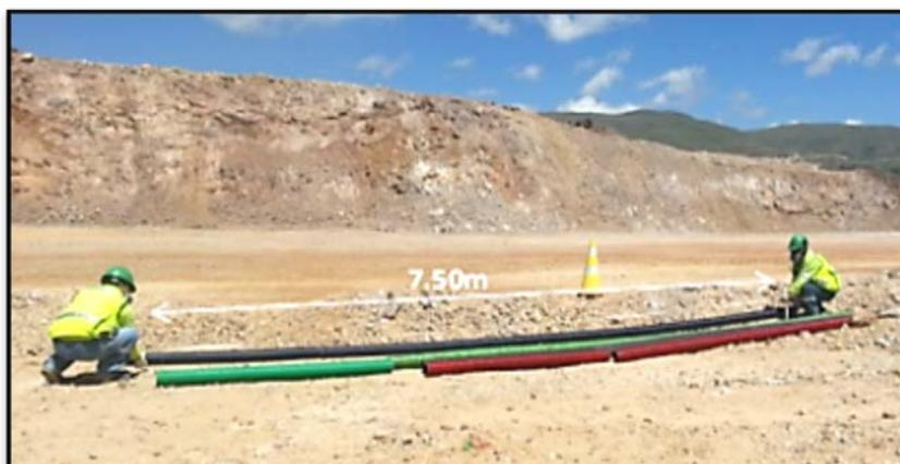
**FIGURA 56:** Medición de tubería total antes de ser instalado en el pozo
