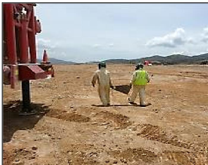
**FIGURA 19:** Traslado de muestra de detritos, en bandeja de muestreo
