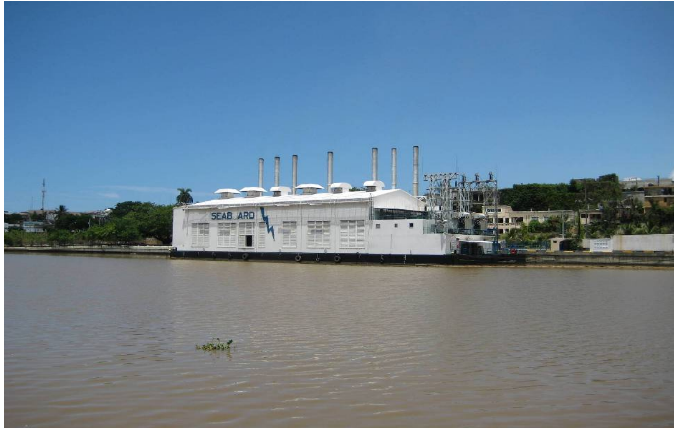
Figura Nº 5.34.- Monte Rio Power Plant (100 MW)
