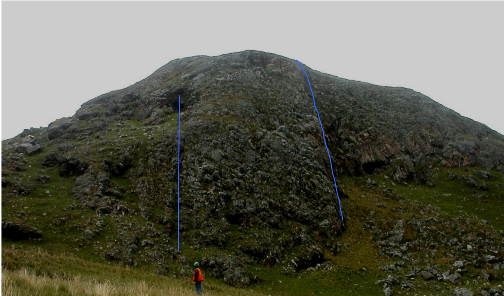
FOTO N°17: Afloramiento de fallas, obsérvese de izquierda a derecha las fallas Baritina y el Águila respectivamente, foto mirando hacia el sur oeste.
