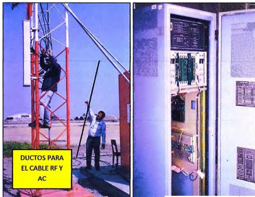
Fig. 3.14 Instalación del cableado RF y ducterías para cableado RF – AC , y equipo Trayectoria de Planeo. (Foto tomada durante la instalación)
