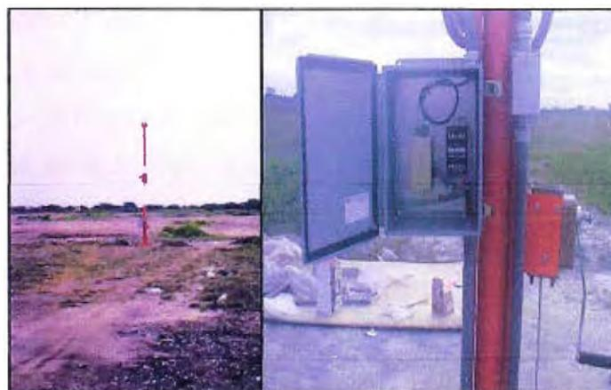
Fig. 3.17 Antena Monitora de campo cercano y Detector Integral.
