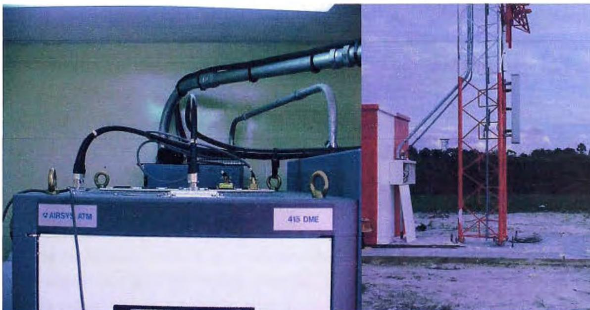
Fig. 3.34 Conexión RF del equipo DME y antena DME instalada en la torre de antena. (Foto tomada durante la instalación)
