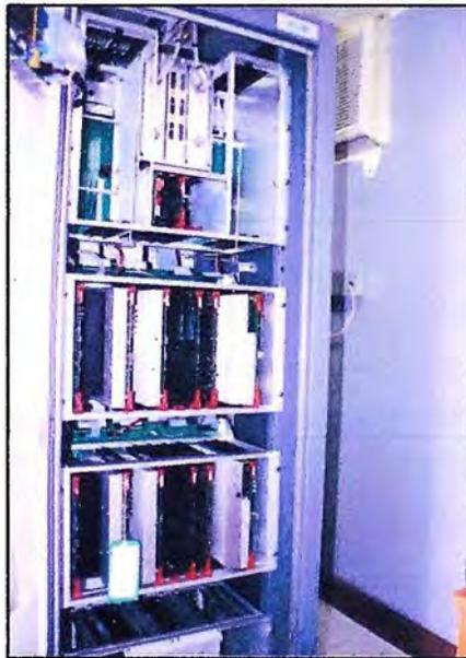
Fig. 3.32 Equipo DME, con módulos y tarjetas instaladas.
