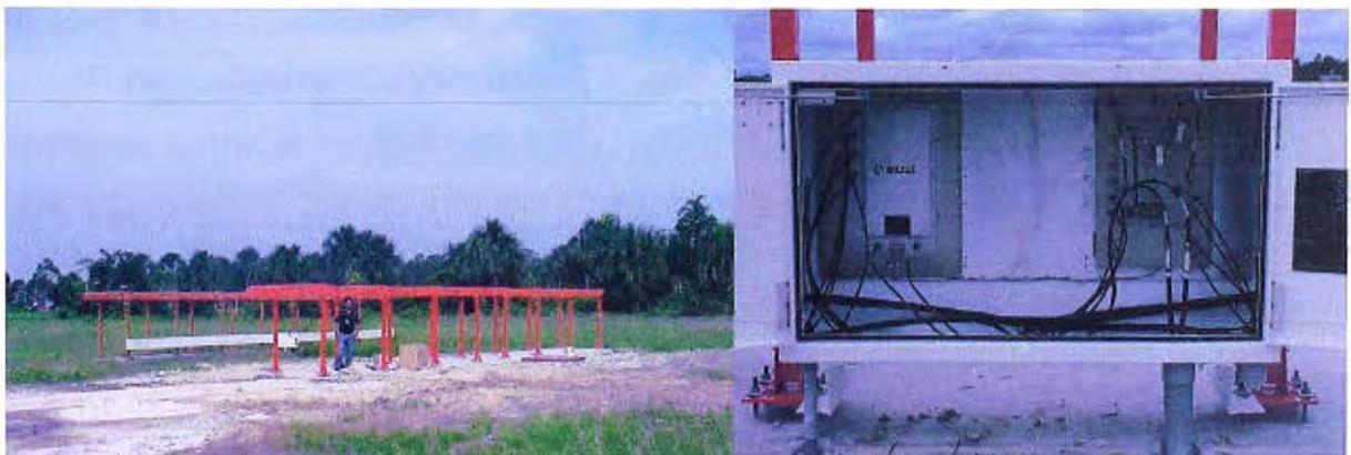
**Fig. 3.5** Instalación del sistema de antenas y modulo de distribución y combinación cableado. (Foto tomada durante la instalación)
