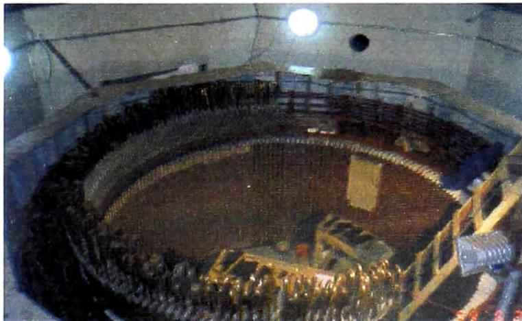
**Fig.2.1 Montaje del estator en la Central Hidroeléctrica San Gabán II**
