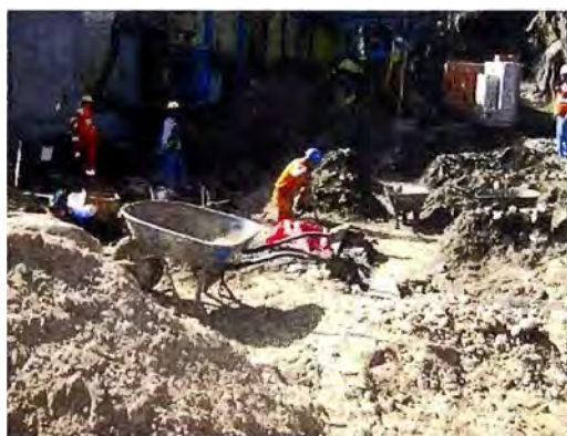
Fig.4.12 Relleno con Tierra de Chacra
