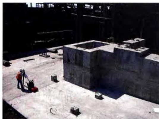
Fig. 4.8 Pedestales de molino
