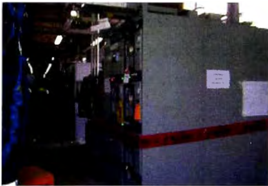
Fig. 4.19 Montaje de Switchgear, MCC
