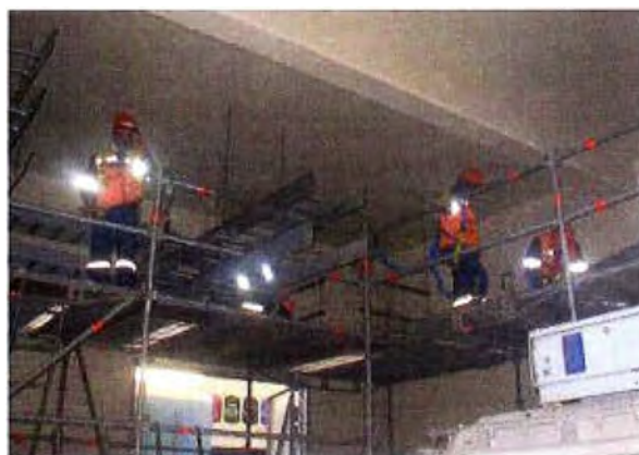
Fig. 4.16 Cableado, conexión en SE 9A
