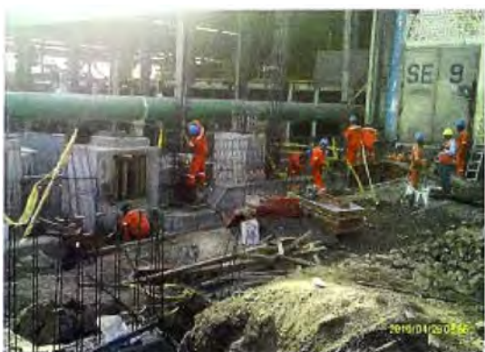
Fig. 4.9 Armado de muro de la SE.
