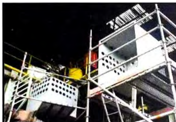
Fig.4.14 Montaje de Cajas Eléctricas
