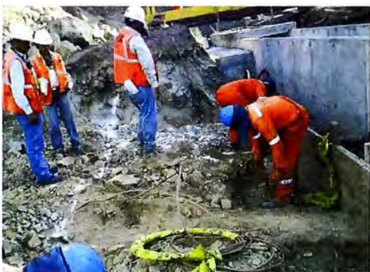
Fig.4.11 Excavación de malla a tierra
