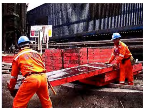
Fig.4.5 Encofrados en Obra
