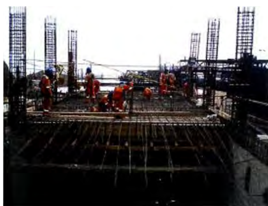
Fig.4.10 Trabajos en losa de subestación
