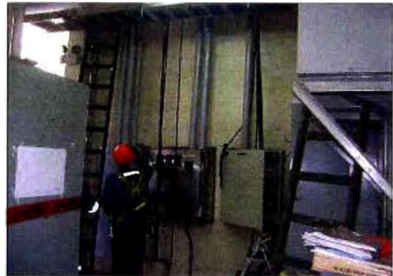
Fig. 4.20 Montaje de tableros, entubados
