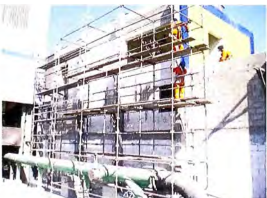
Fig.4.11 Acabados en SE 9A
