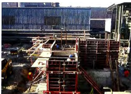
Fig.4.7 Encofrados de pedestales molino
