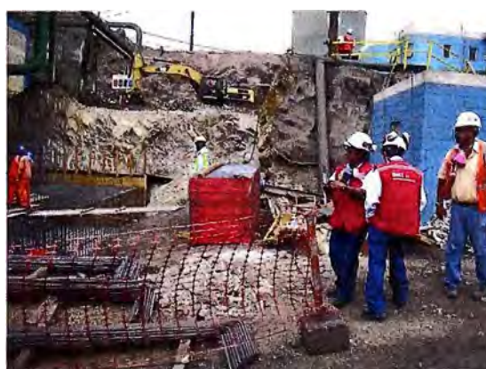
Fig.4.6 Supervisión de Obras
