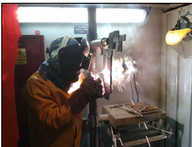
Figura 2.6: Soldadura del cupón en posición vertical – parte 1
