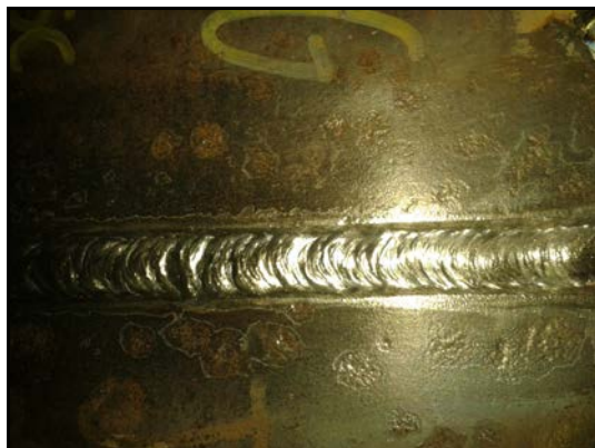
Figura 2.14: Acabado aceptado visualmente – parte2
