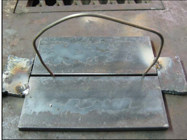
Figura 2.3: Preparación del cupón
