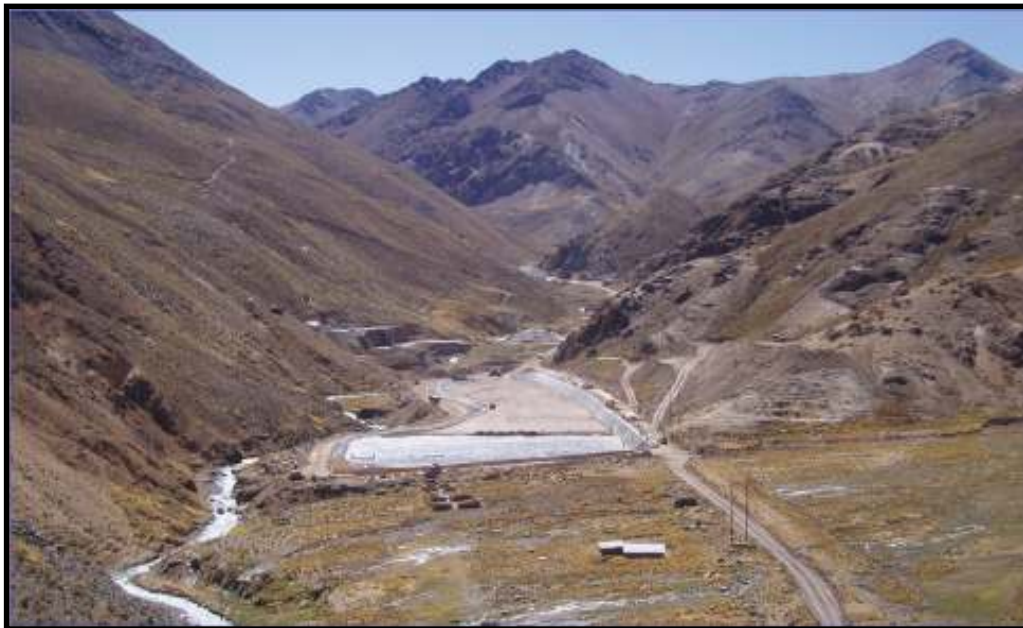
Fig. 7: Vista Panorámica del Proyecto mirando al noreste, se observa el río Huancarama, hacia el lado derecho Layo Sur y hacia el lado izquierdo Layo Norte.
