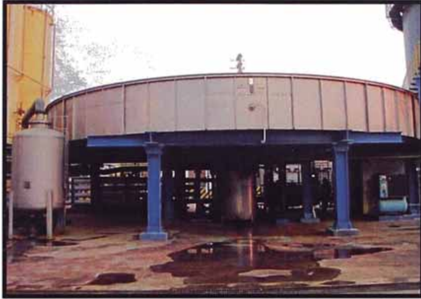
Figura 20: Celda de Clarificación
