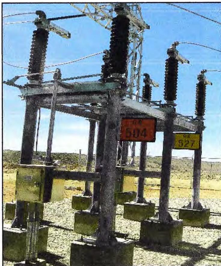
**Figura 1.6: Seccionador o Cuchillas de puesta a tierra**
