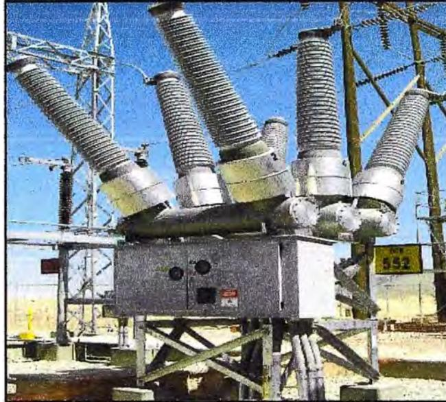
**Figura 1.7: Interruptores en SF6 (hexafluoruro de azufre)**
