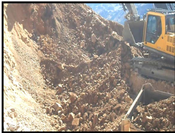
Figura 3.8. Foto de voladura y minado
