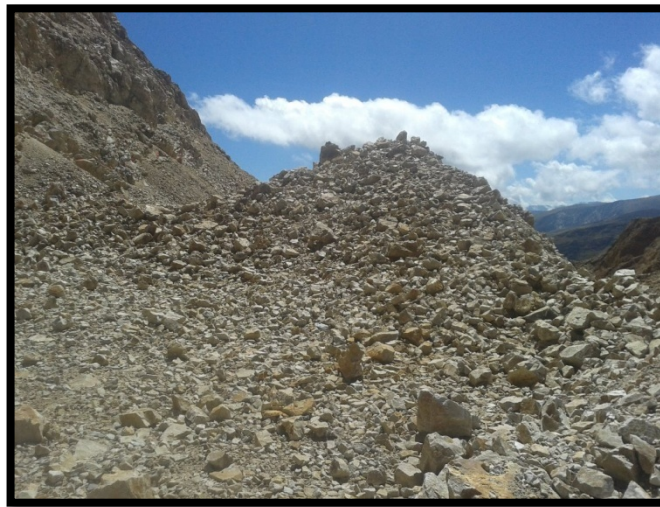
Figura 5.9. Foto de Voladura en desmonte.
