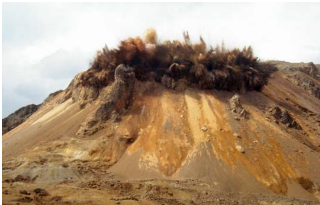
Figura N° 2.2 Voladura, Banco 5040 Polígono 179, lado Este del tajo Tucari.
