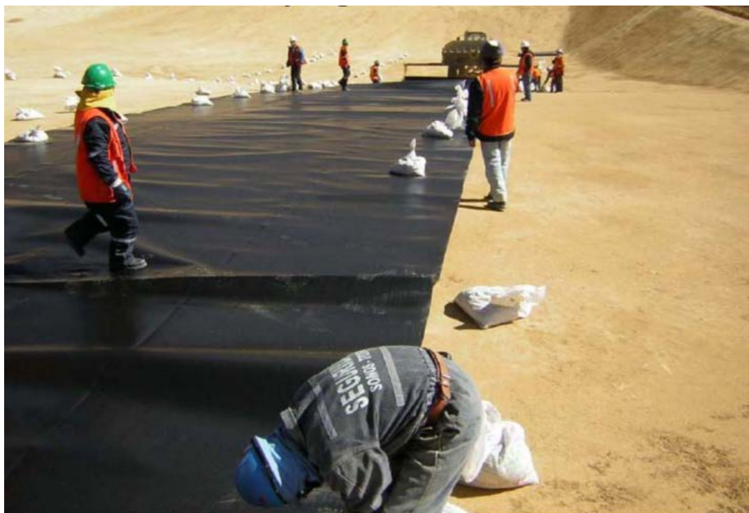
Figura N° 2.9 Tendido de geomembrana luego de colocar la rasante, conformado de arcilla.
