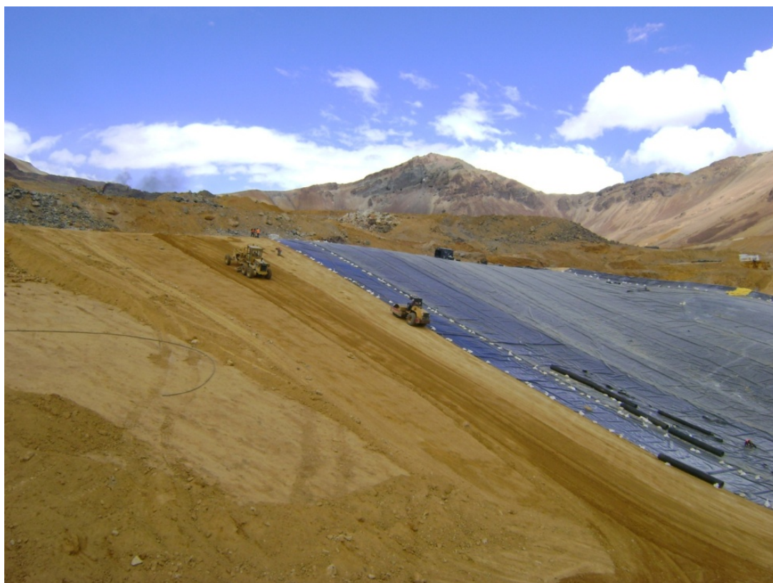
Figura N° 2.7 Conformación de la subrasante (relleno estructural) según planos de construcción para recibir la arcilla.
