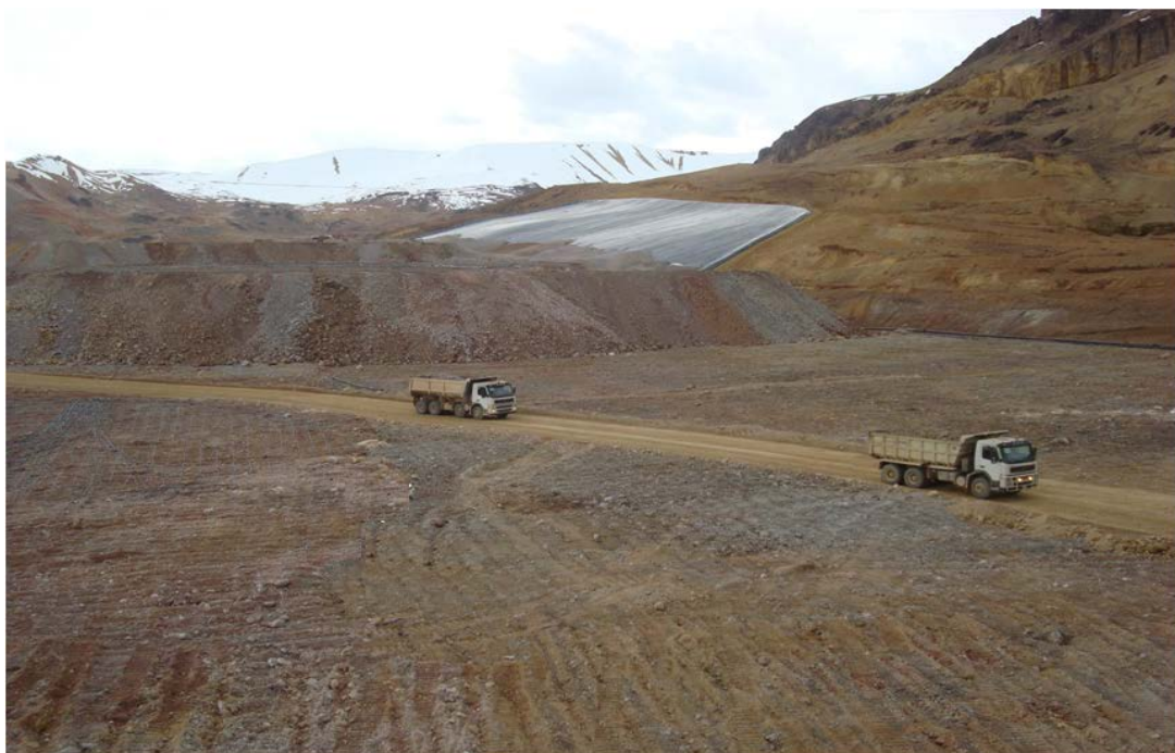
Figura N° 2.4 Transporte de mineral al Pad de Lixiviación 23,500 TM diarias.
