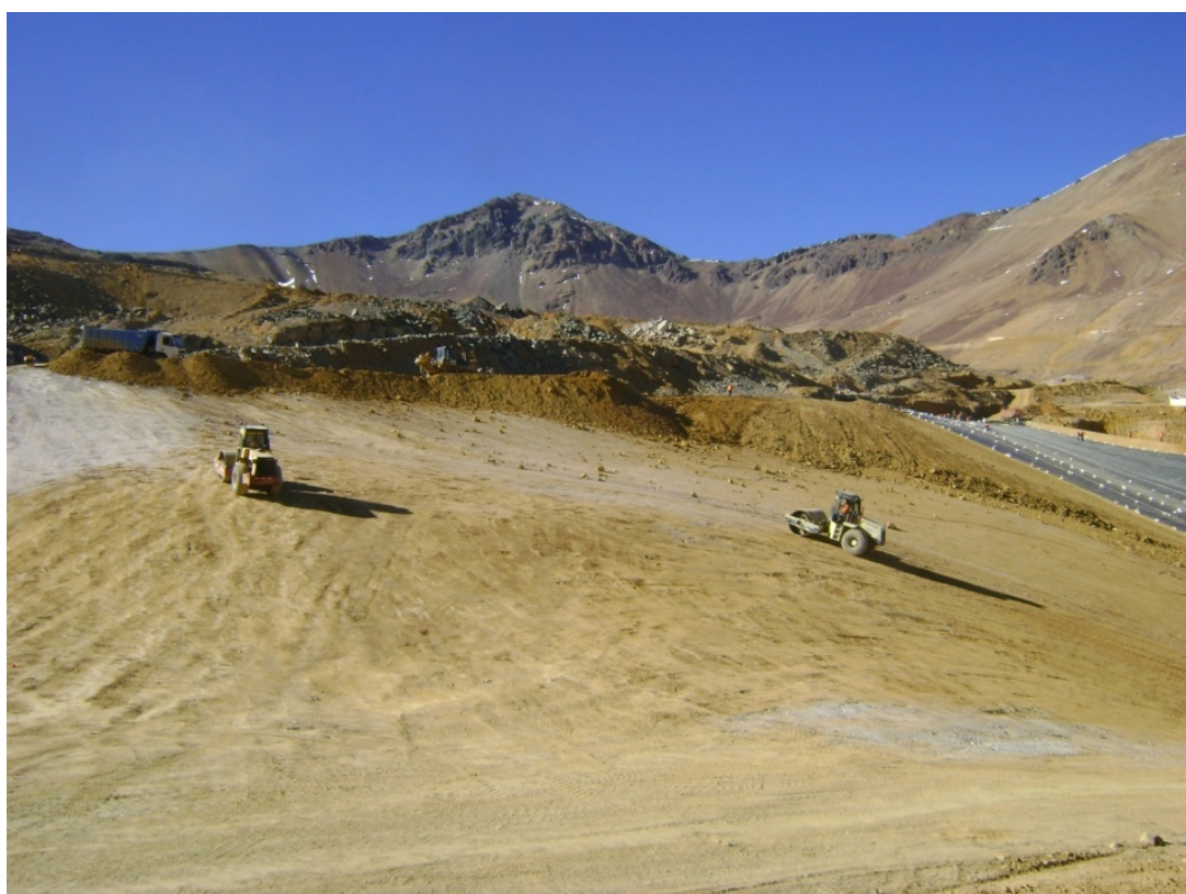
Figura N° 2.8 Conformación de la rasante y compactación de la arcilla.
