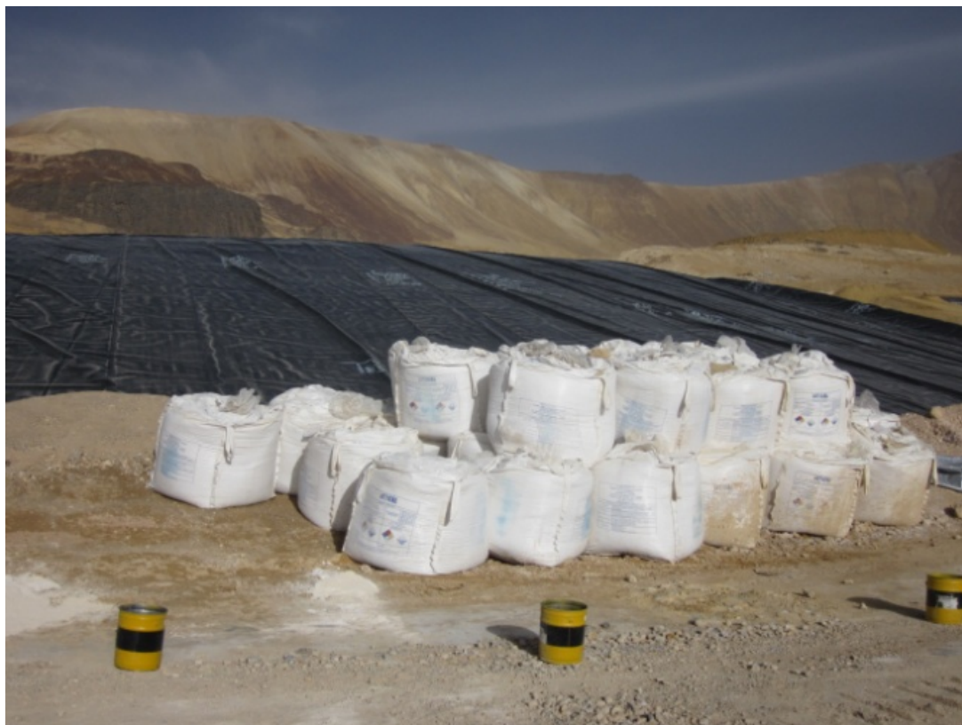
Figura N° 2.20 Almacenamiento de cal en la zona de descarga del Pad de Lixiviación.
