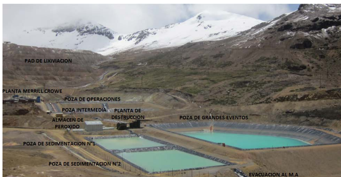
Figura N° 2.42 Vista general de la destrucción de cianuro de sodio.
