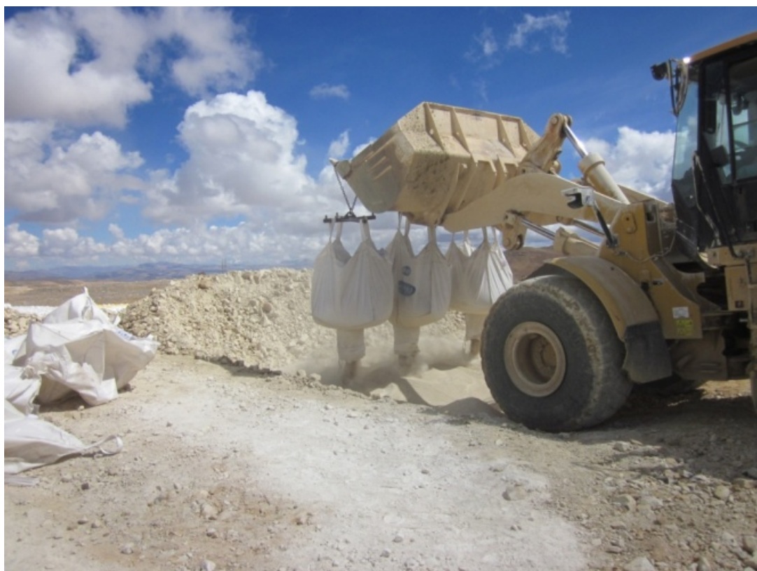
Figura N° 2.21 Dosificación de cal, cada bolsa es de 1 tonelada.
