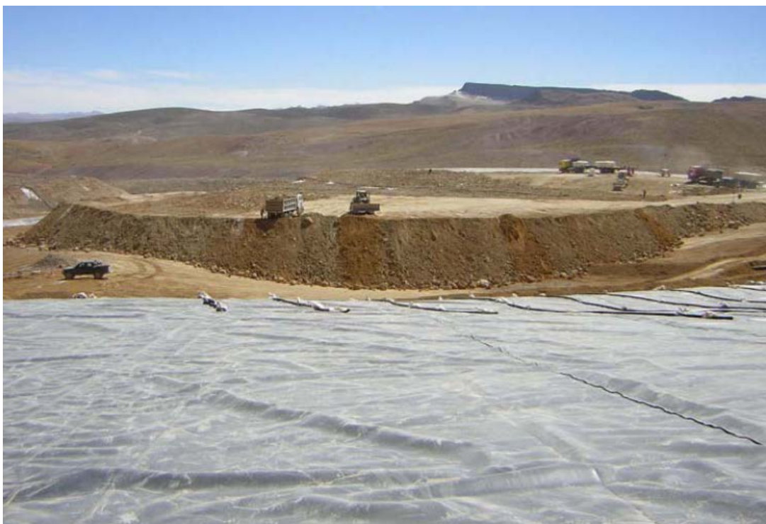
Figura N° 2.17 Llenado del Pad de Lixiviación.
