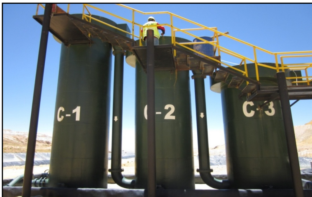
Figura N° 2.40 Ingreso de solución cianurada de 150 m 3 /h.
