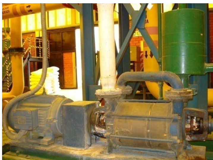
Figura N° 2.30 Bomba de vacío modelo LPHX 65320.
