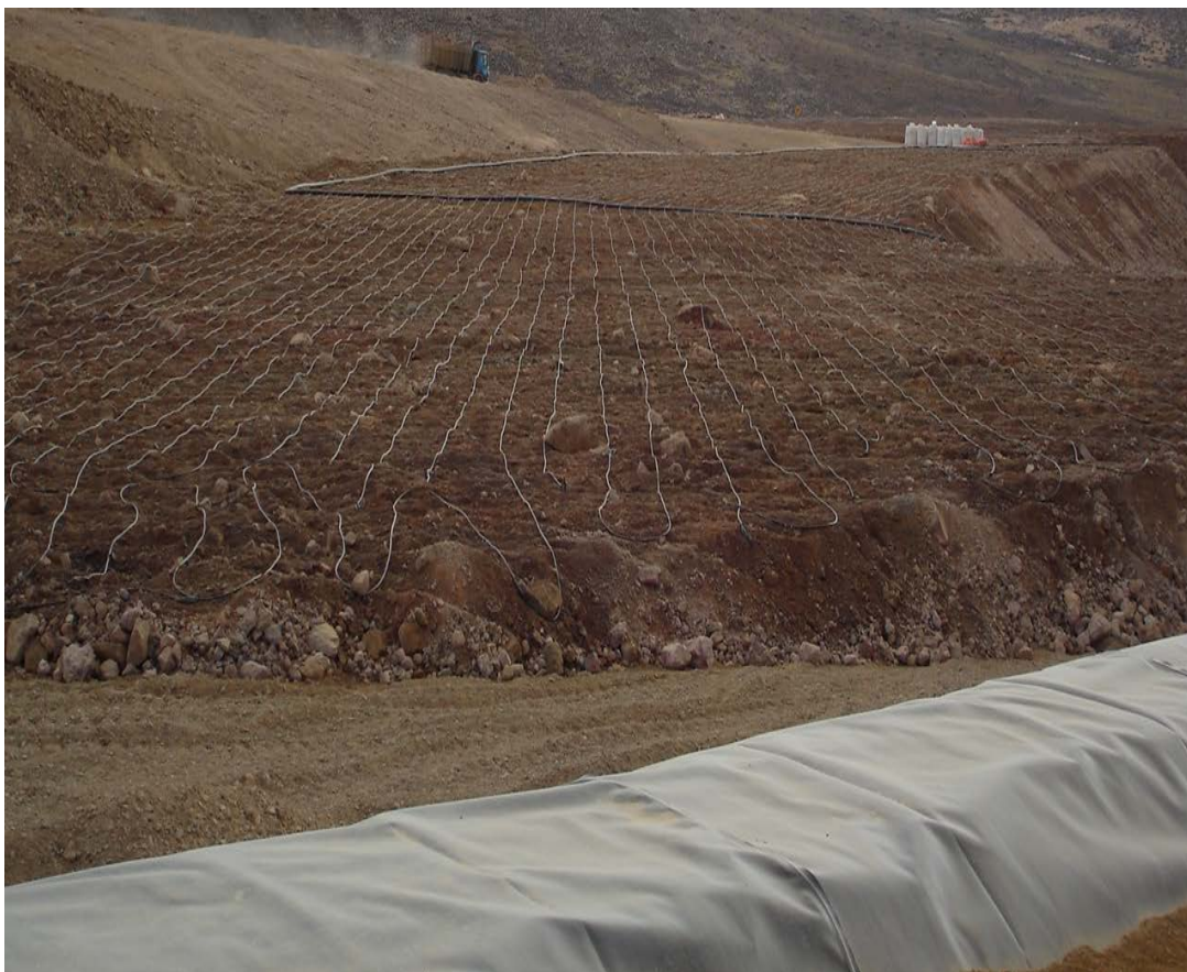
Figura N° 2.23 Armado de Celdas de Riego, celda N° 33 Lift 3.
