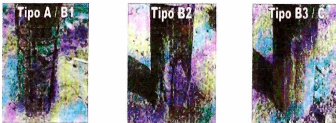
Fig 3.12.-Categoría del poste de Luz del Sur según su estado.
