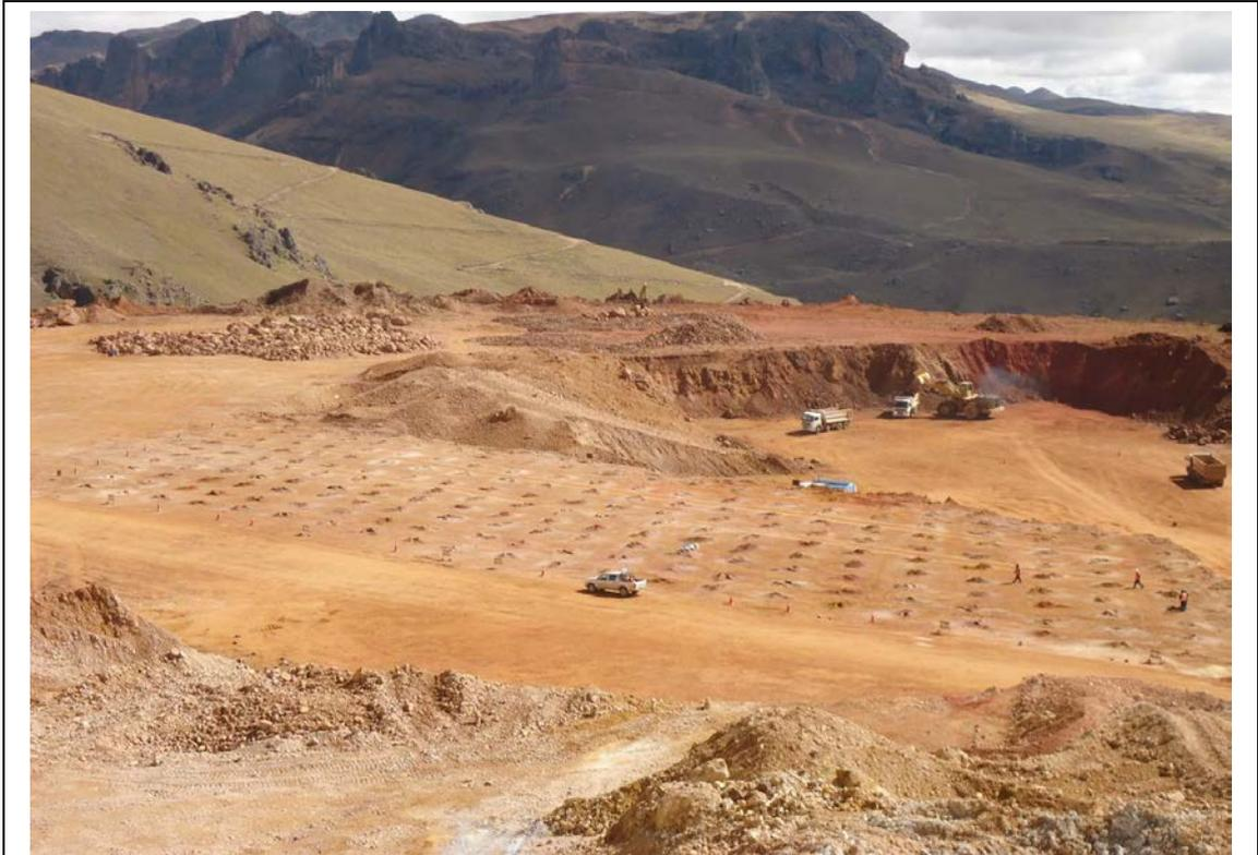
**FIGURA N° 21.- Ejemplo de una malla perforado # 15 banco 4512.**
