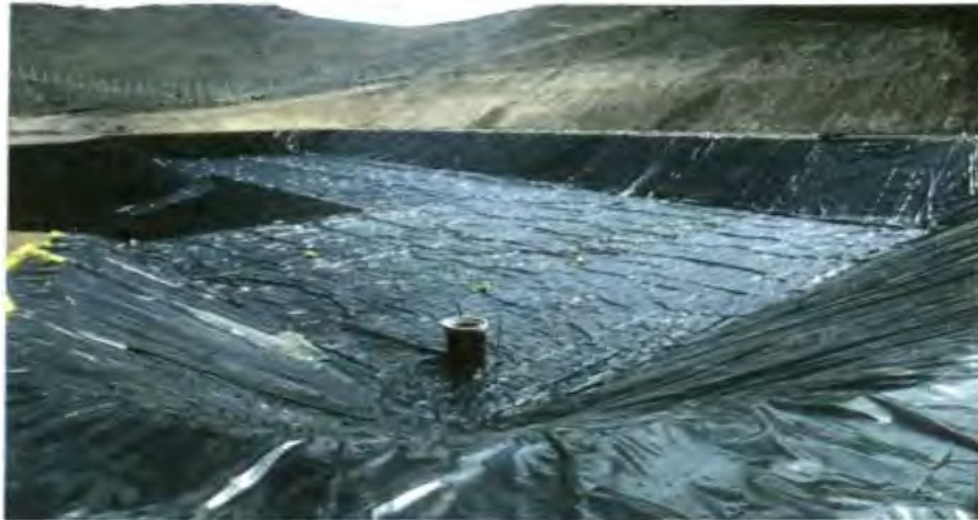
Figura 15: Relleno de seguridad
