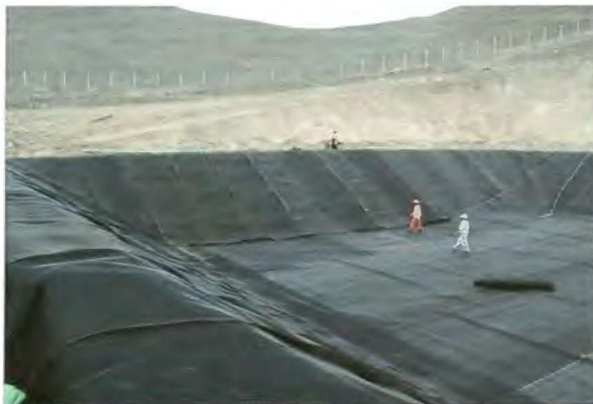
Figura 16: Relleno de seguridad
