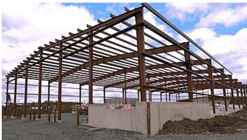
Figura 1.2 Instalación erigida con perfiles estructurales
