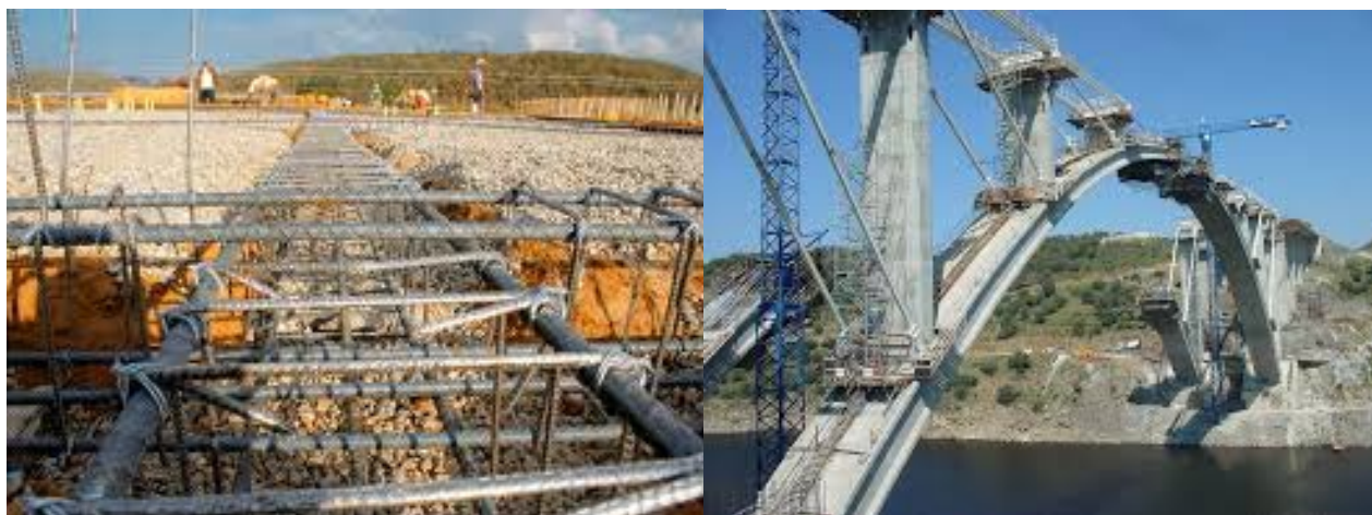
Figura 1.4 Instalación erigiéndose con barras estructurales
