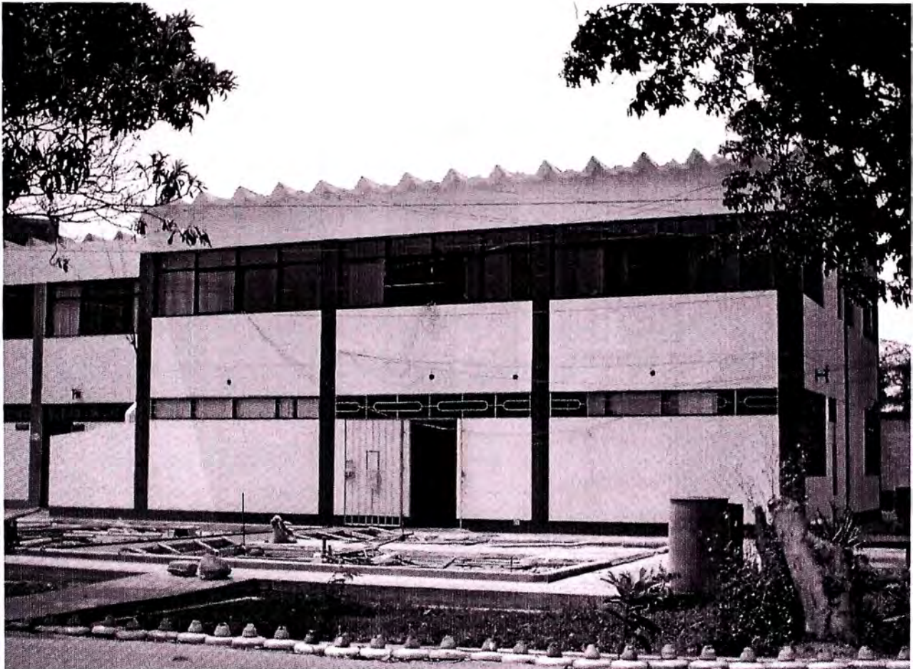
Figura 4. Nuevas Instalaciones del Centro de Control de Operaciones , en ella la Supervisión de Operaciones es la responsable de la operación y control de todas las Subestaciones del Sistema Eléctrico de HIDRANDINA, entre ellas las que están implementadas al Sistema SCADA.
