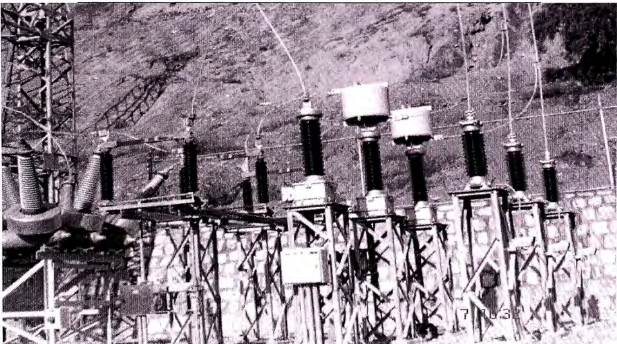
Figura 34. Ubicación de las Trampas de Onda en la S.E. Huallanca Salida Caraz
