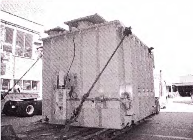
Fig. 6. Transformer braced with steel ropes Fig. 6. Transformador asegurado con cables de acero
