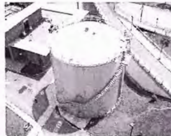
TANQUE DE ALMACENAMIENTO
