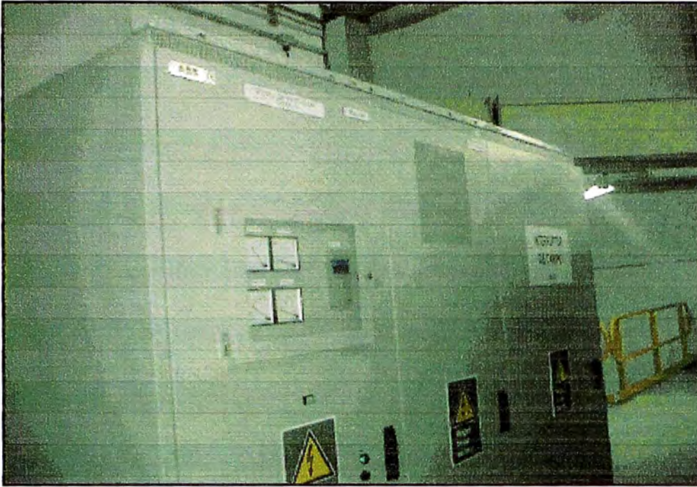
FIG. N° 5.5 REGULADOR DE TENSIÓN
