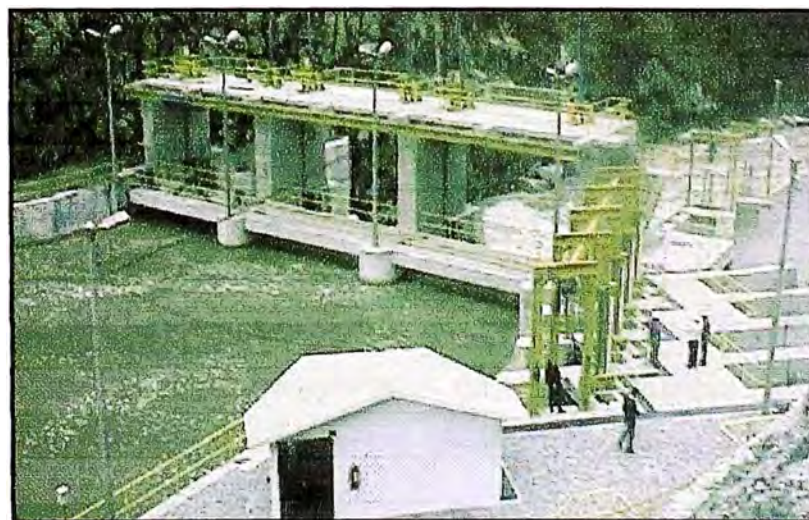
FIG. N° 3.1 VISTA DE COMPUERTAS DE LA TOMA TARMA
