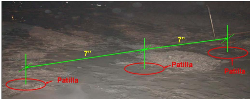
FIGURA 5.6: POSICIONAMIENTO DE LAS PATILLAS
