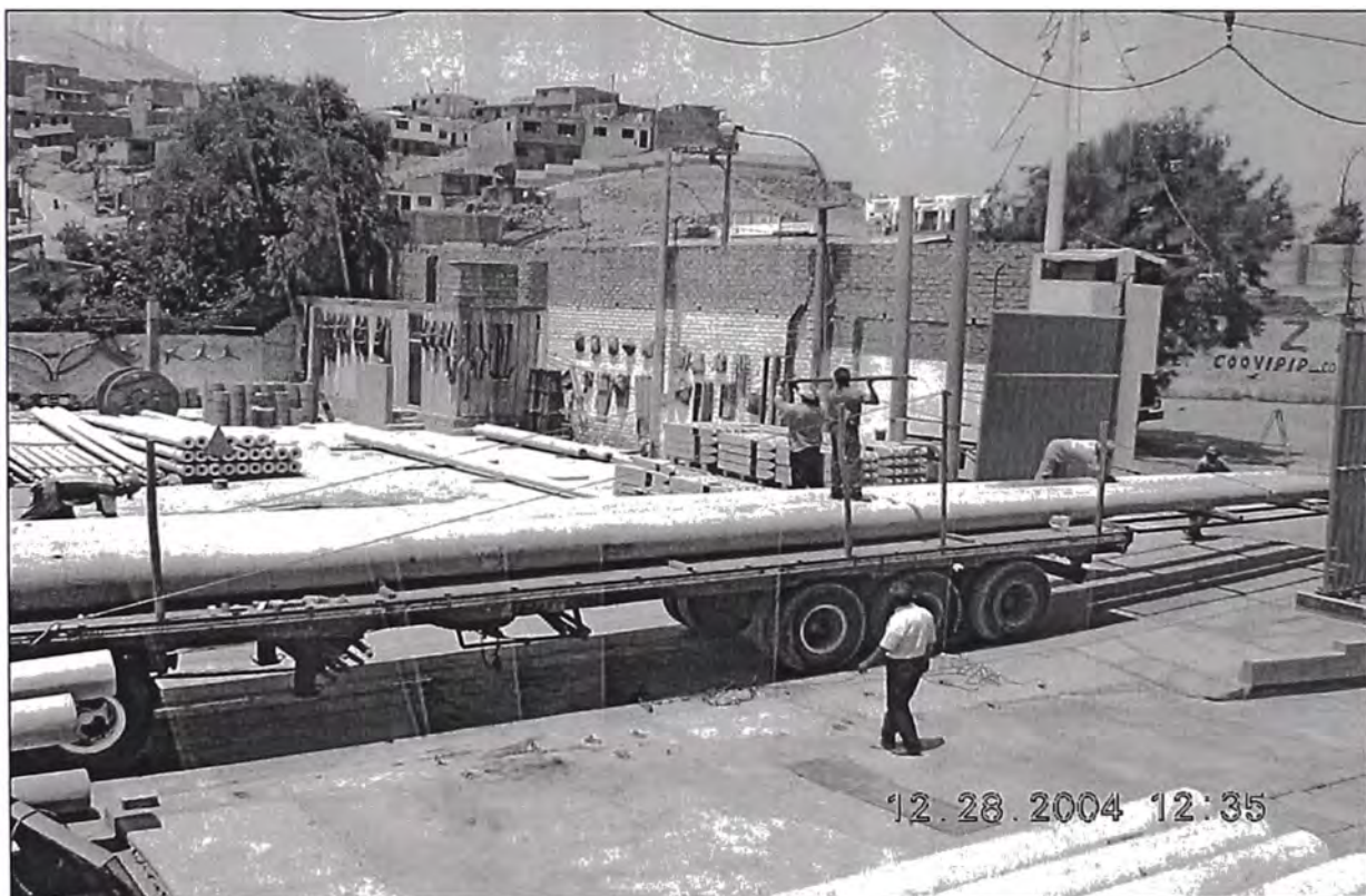
Fig. N° 4.30: Transporte de postes de 18m a obra 1
