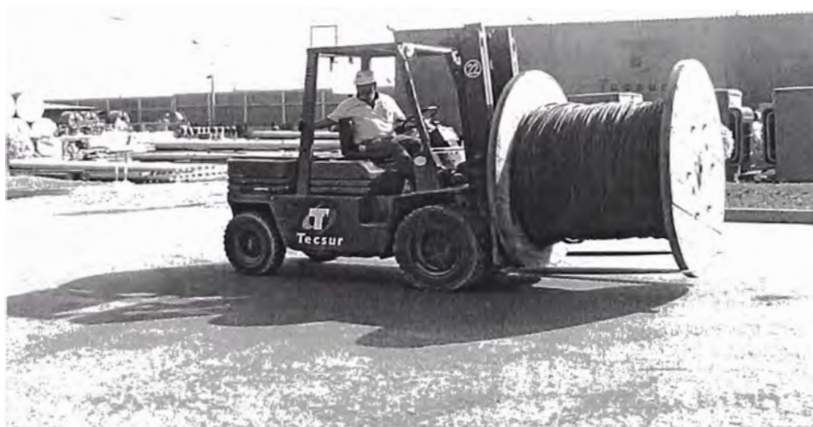
Fig. N° 4.16: Transporte de Conductor.
