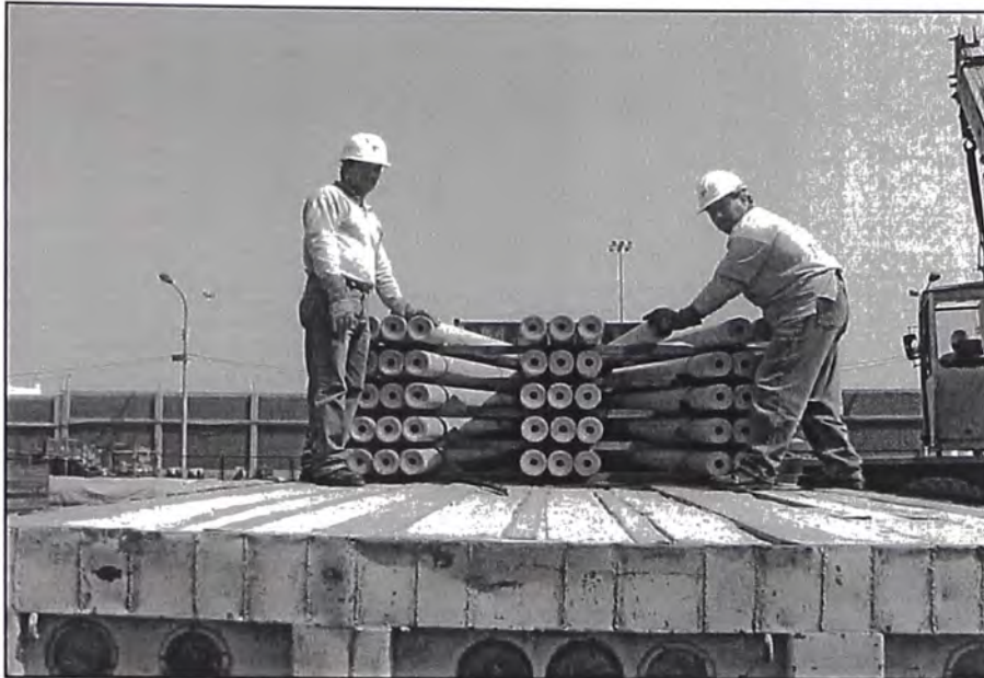
Fig. N° 4.20: Colocación de estrobos
