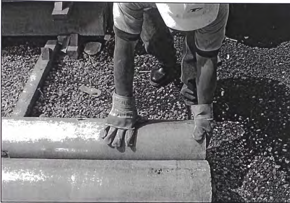
Fig. N° 4.22: Posicionamiento de postes.
