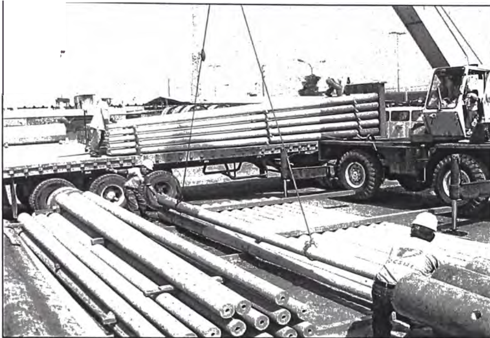
Fig. N° 4.23: Termino de trabajo.
