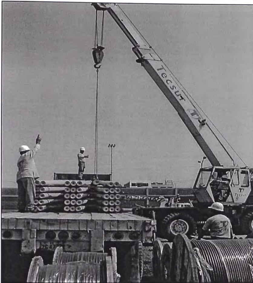
Fig. N° 4.21: Izaje de Postes
