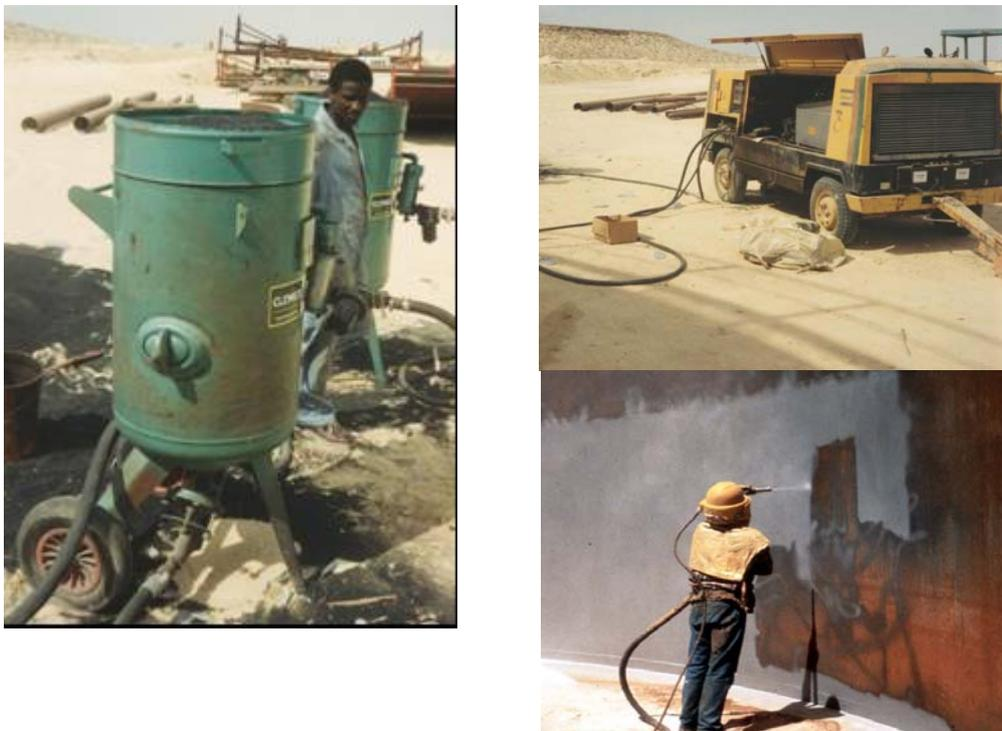
Fig. 6 Equipos para el "Arenado"
