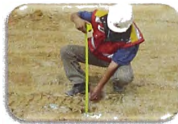
Figura 1.16 Medición de la altura de Taco
