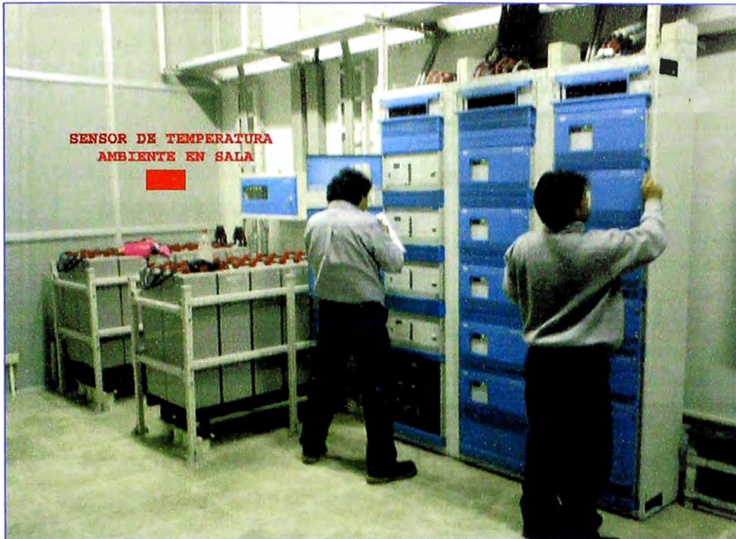
Figura 5.7: Disposición del Sensor de Alta Temperatura de Ambiente
