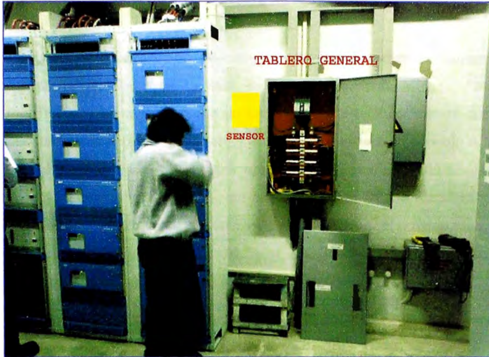
Figura 5.4: Ubicación del Sensor de Falla de Red
