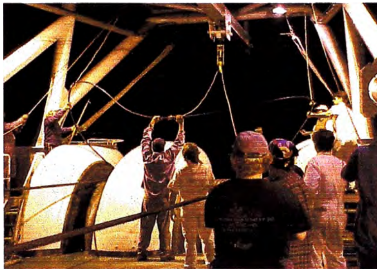
Fig. 2.32. Colocando el final del cable al mar
