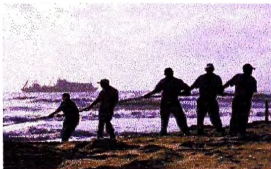
Fig. 4.4. Enterramiento del Cable Submarino en la Estación Terrena
