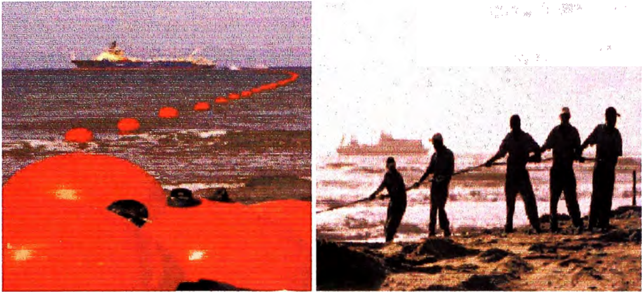
Fig. 2.18 Boyas durante el Direct Landing
