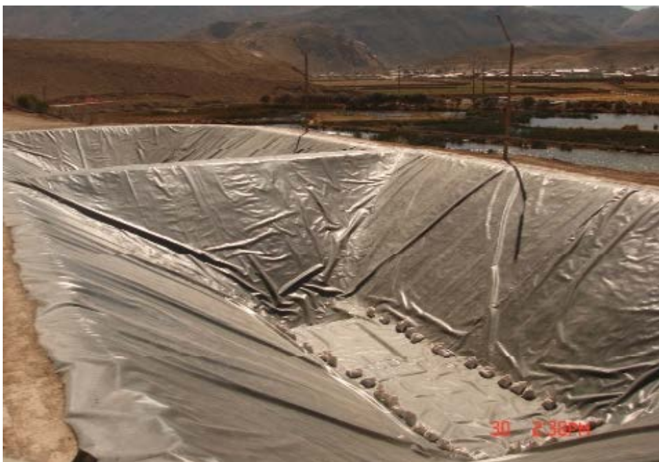
Figura. 4.5. Pozas de almacenamiento de agua tratada (800 m 3 )
