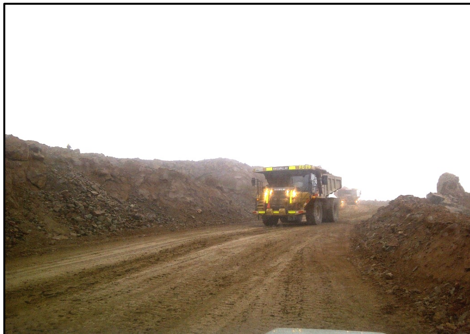
Figura 1.14 Camión CAT 775E trasladando material [19]
