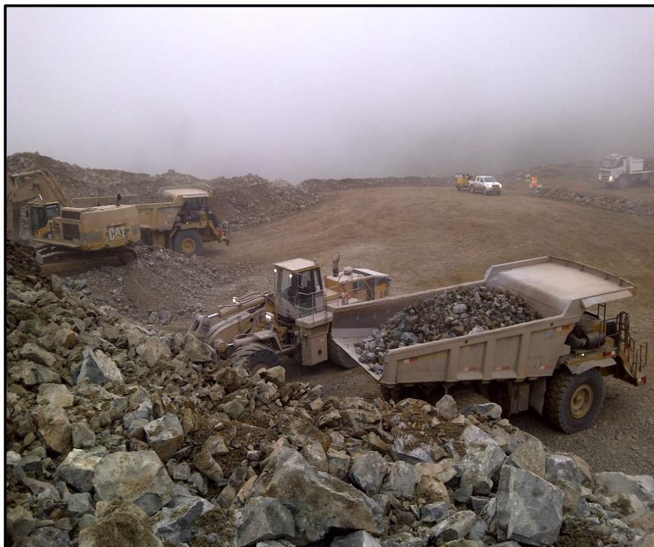
Figura 1.15 Equipos en actividad [20]
