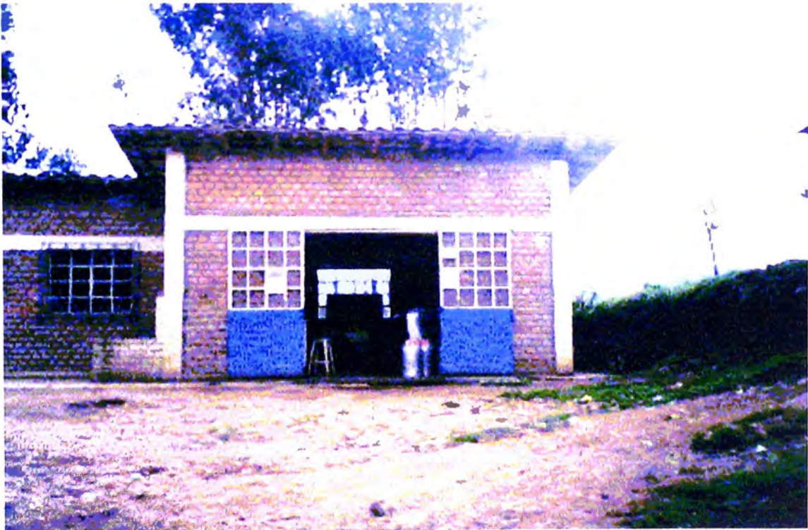
VISTA DE PLANTA LECHERA
