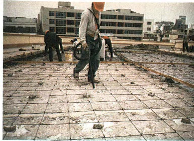
Se inician los procesos paralelos, succión de partículas y aplicación de puente de adherencia.
