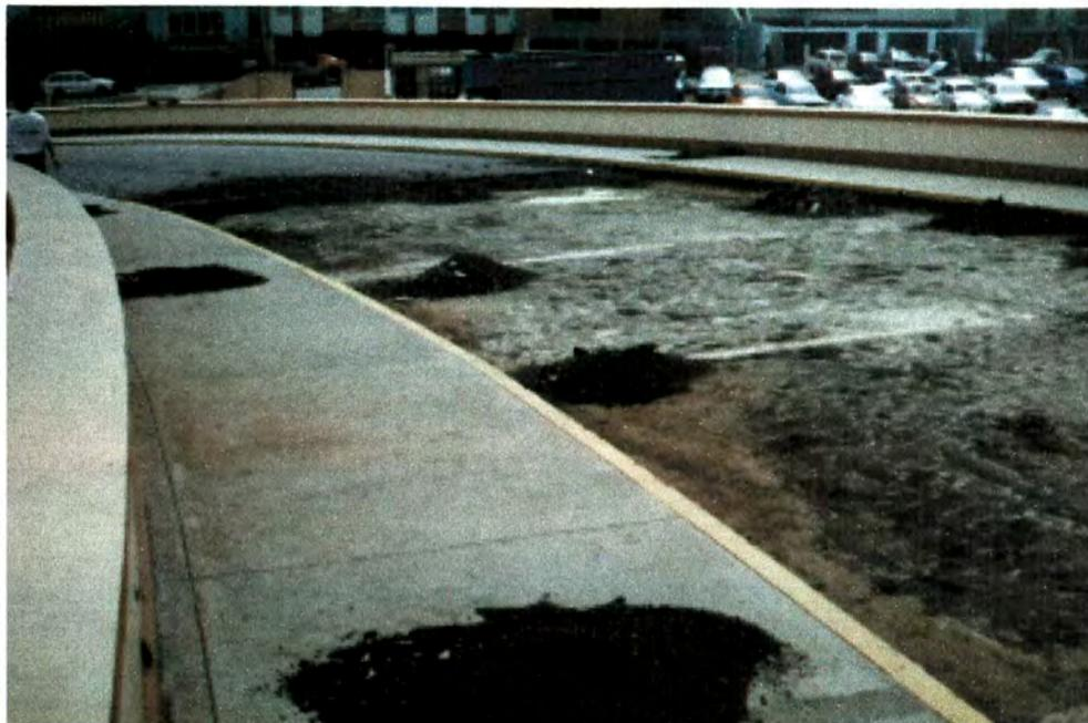
Se notan las juntas de construcción, punto de inicio de las filtraciones.
