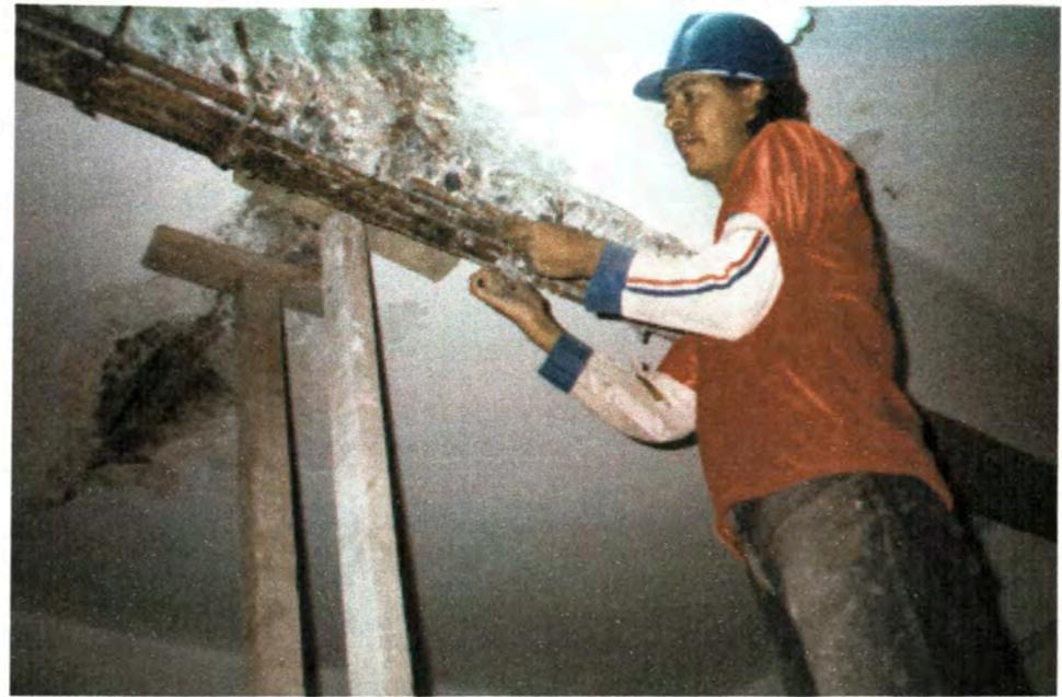
Se inician los procesos de remplazo de aceros corroídos y consolidación de vigas y cielorrasos.
