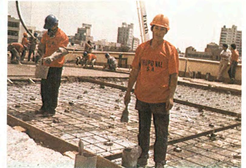
Aquí se aprecia al equipo de colocación de concreto, vibrado, compactación, frotachado y marcado de juntas.
