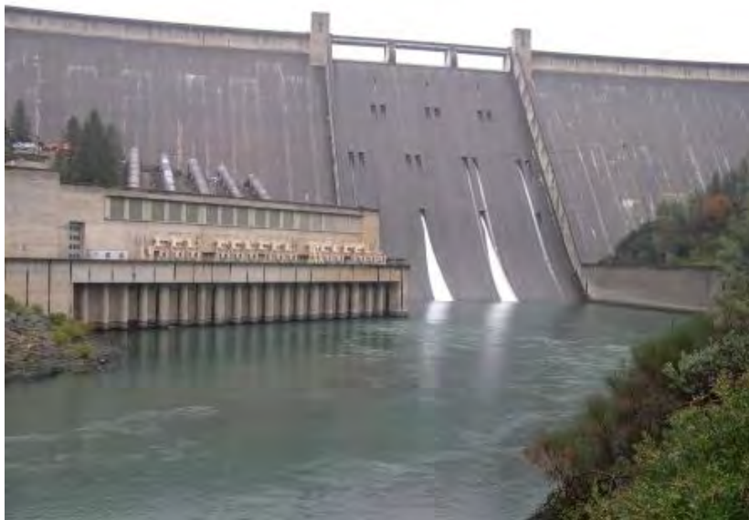
Fotografía N° 13.1 Presa de Gravedad
