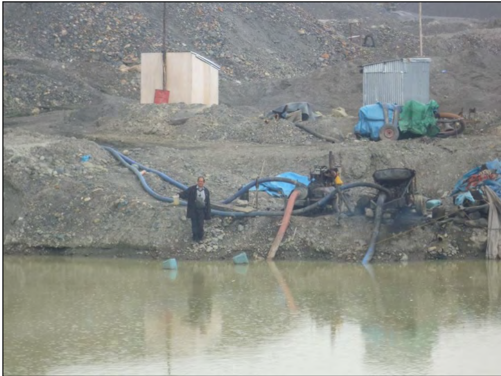
Figura N°6.15 Monitoreando en la Poza de Sedimentación N°4, llamada Clarificador, observándose agua clarificada y las bombas – mangueras de succión para retornar al proceso de producción, “Circuito Cerrado del Agua”.
