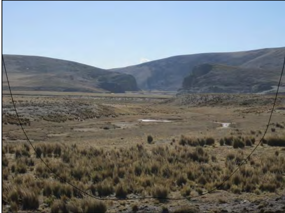
Figura N°6.24 Ubicación de la Presa a construir. Vista panorámica desde aguas abajo hacia aguas arriba.
