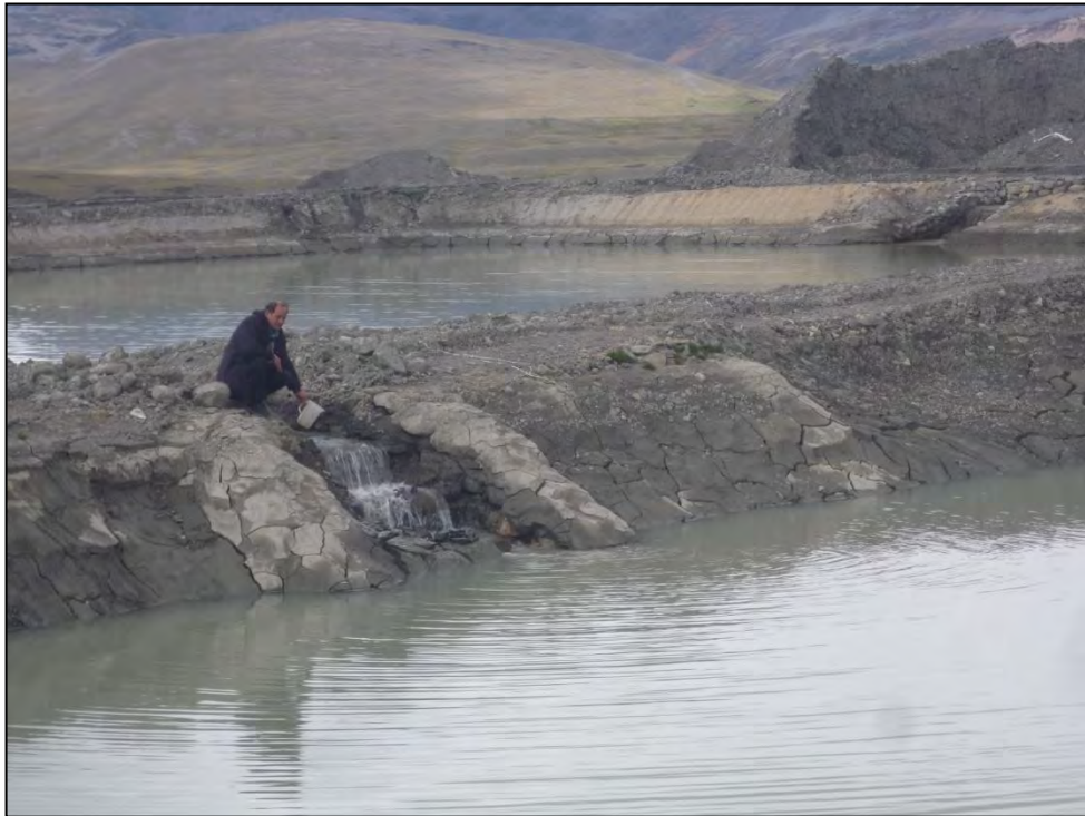
Figura N°6.13 Monitoreando al ingreso a la Poza N°3, Sedimentación
