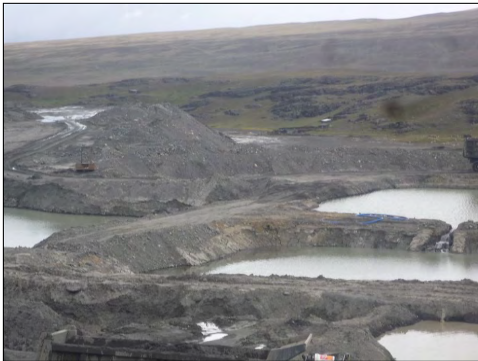
Figura N°6.14 Una vista panorámica de las (4) pozas de sedimentación y las Pozas de lodo.
