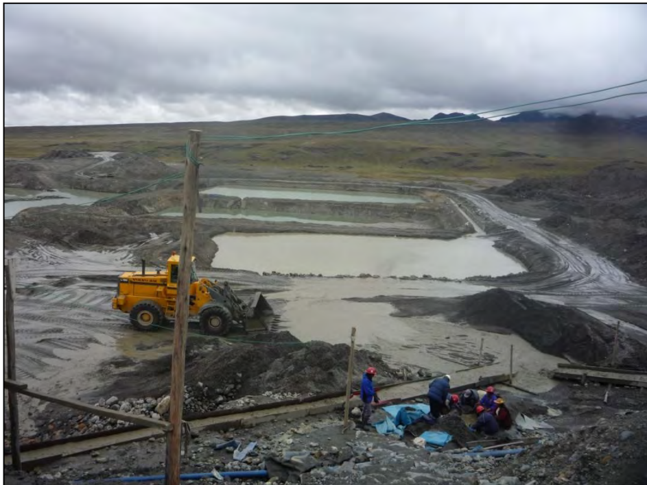
Figura N°6.10 El tratamiento del mineral utilizando las canaletas que contiene las arenas negras con oro y las pozas de sedimentación.
