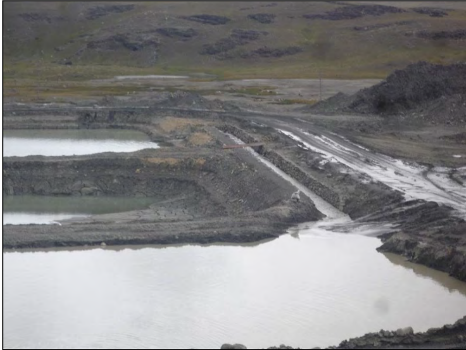
Figura N°6.11 Se observa primero la Poza N°1 Desarenador, luego la Poza N°2, Poza N°3, Sedimentadores.
