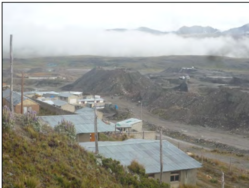
Figura N°4.7 Al fondo el río Ramis, en la margen izquierda la población de Ananea y a lado derecho desmontes inestables
