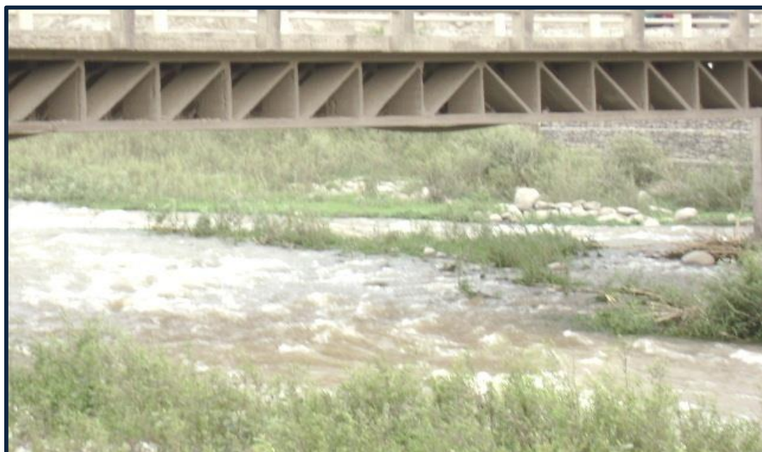
Fotografía N° 8.F E-06-Altura del Puente Magdalena - Yangas, Año 2008
