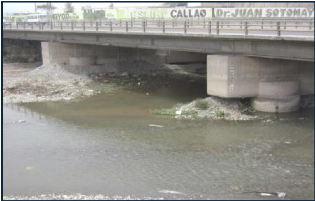
Fotografía N° 11 A Puente de la Av. Néstor Gambeta Callao-E-11
