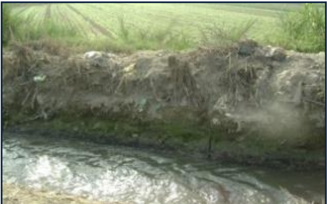
Fotografía N° 6 A Canal de regadío La Cachaza-E-06
