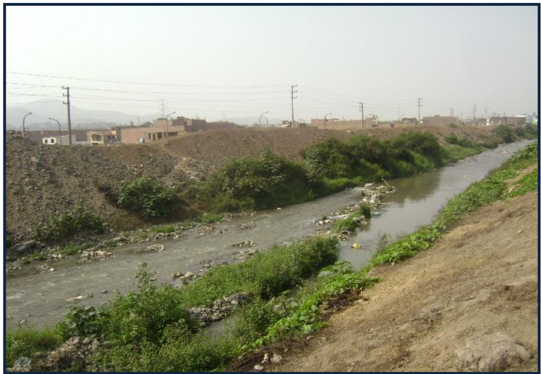
E-10-Puente Chillón Altura de Pro, Año 2010
