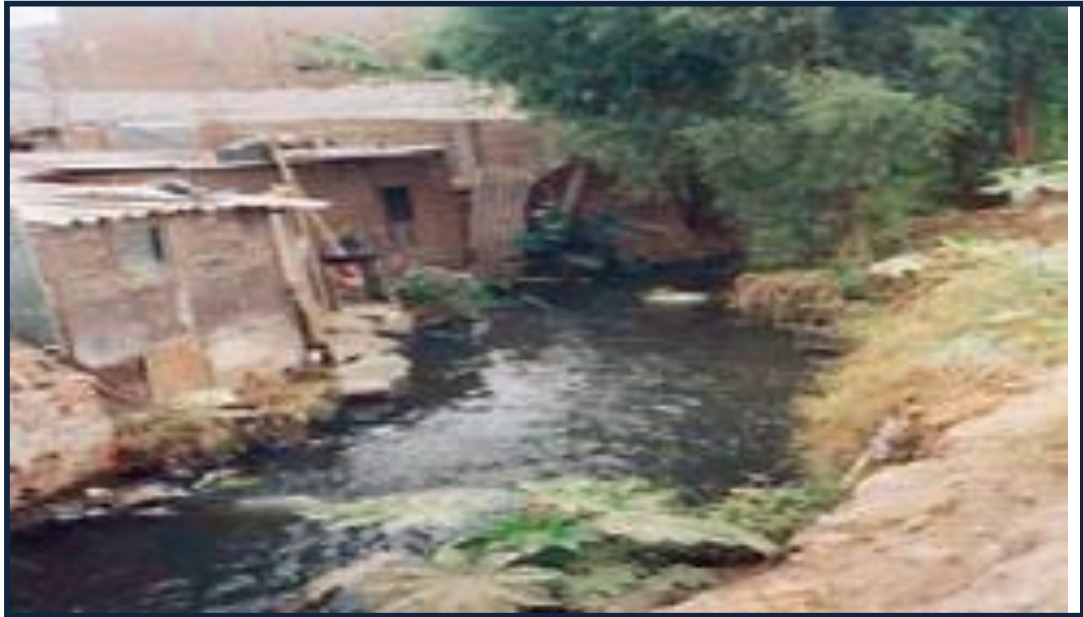
Fotografía N° 9-3 A Peligros latentes de construcción de viviendas ubicadas en la orilla del río Chillón- Carabaylo-Comas
