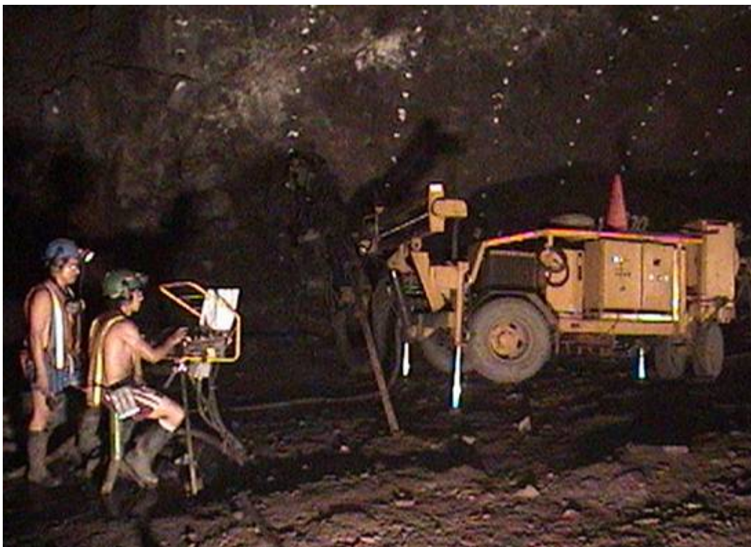
Imagen 4.6: Equipo de perforación.
