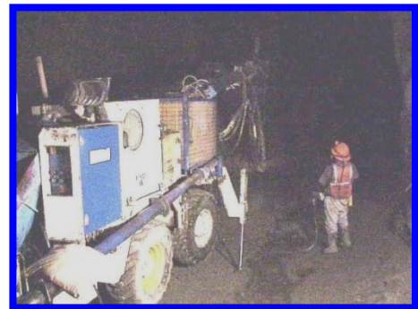
APLICACION DE SHOTCRETE
