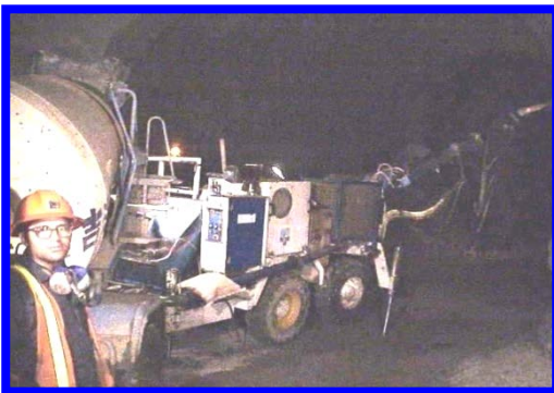
SUMINISTRO DE SHOTCRETE
