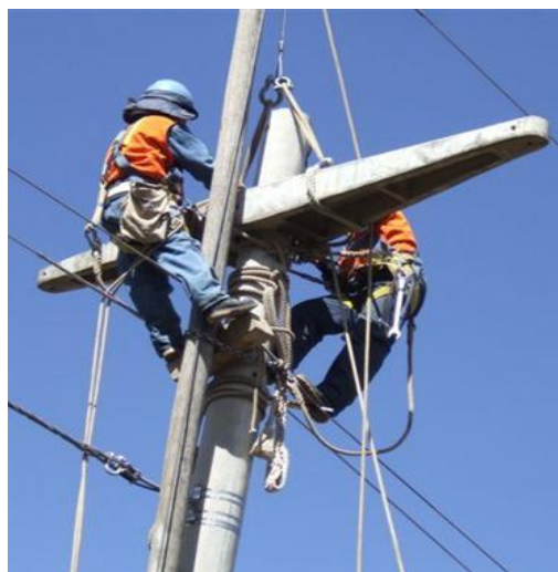
Fig. 2.7: Trabajos realizados en Altura
