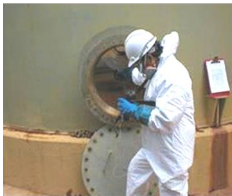
Fig. 2.4: Trabajo en Espacio Confinado Fig. 2.5: Tanque en Reparación
