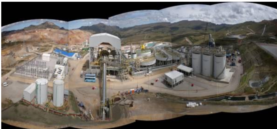
Fig. 1.1: Vista Panorámica del Área de Chancado
