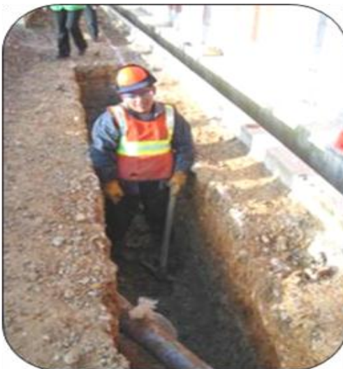
Fig. 2.6: Trabajos de Excavaciones y zanjas
