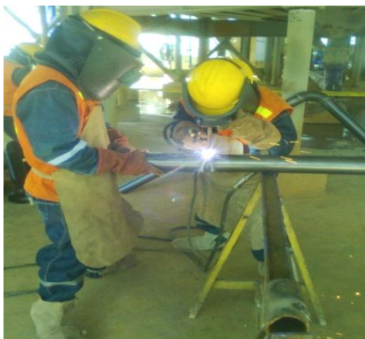
Fig. 2.3: Trabajo de Soldadura
