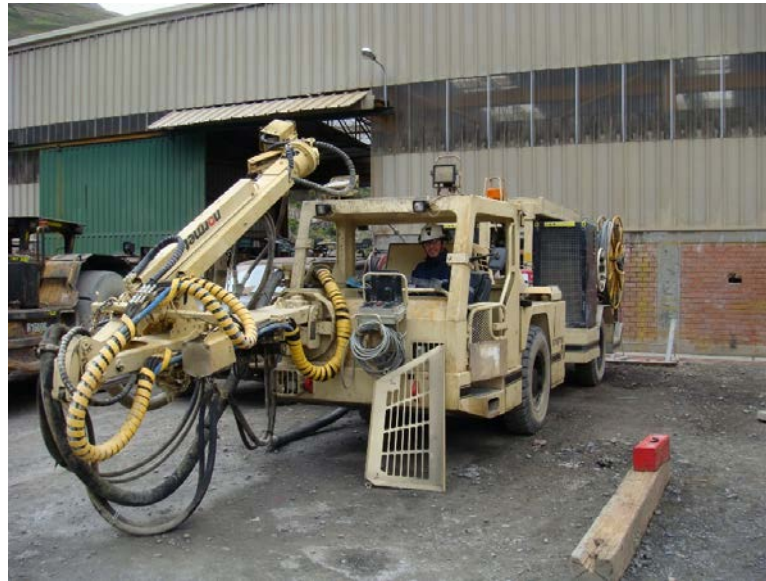
FIGURA 15: ROBOT LANZADOR DE SHOTCRETE NORMET SPRAYMEC
