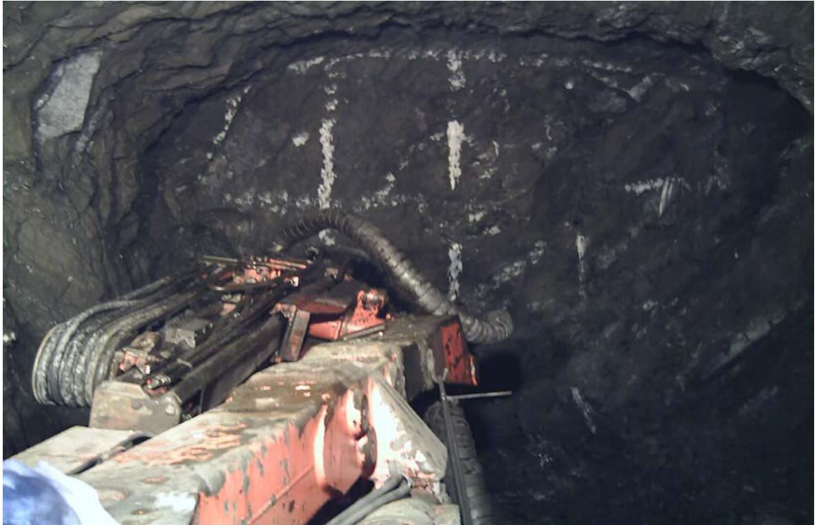
FIGURA 22: PERFORACIÓN EN AVANCE
