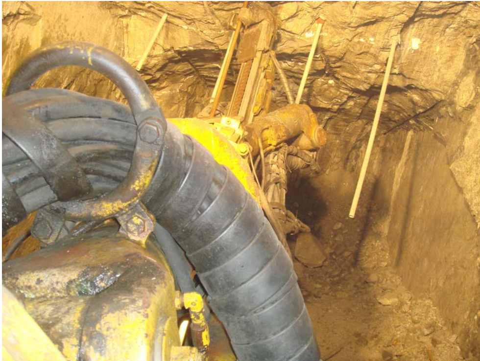
FIGURA 24: PERFORACIÓN RECUPERACIÓN DE PUENTE CON EQUIPO SIMBA
