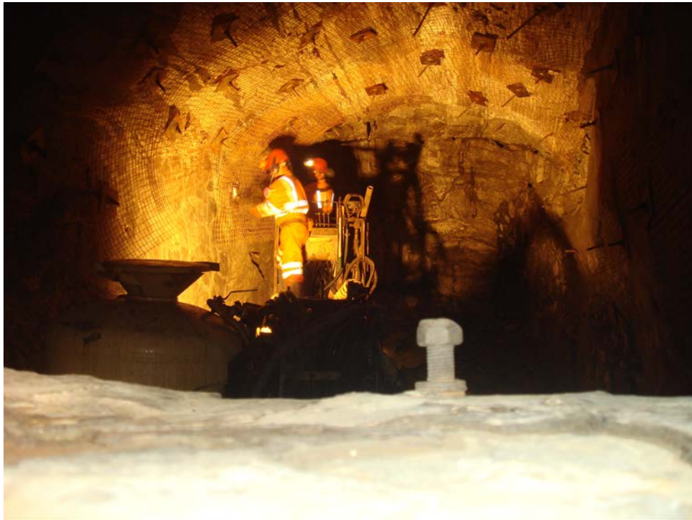
FIGURA 17: INSTALACIÓN DE MALLA ELECTROSOLDADA
