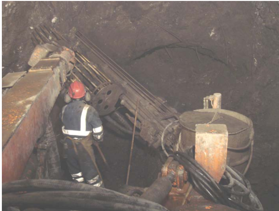
FIGURA 14: COLOCADO DE PERNOS EN LA CASETERA DEL EQUIPO
