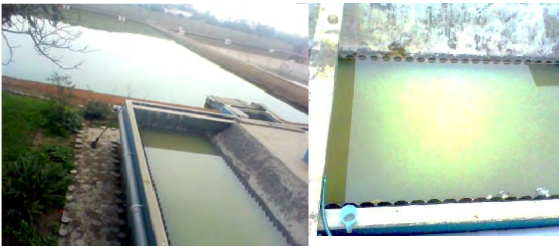
Figura 5.2: Vistas de reactor anaerobio de manto de lodos y flujo ascendente (UASB)
