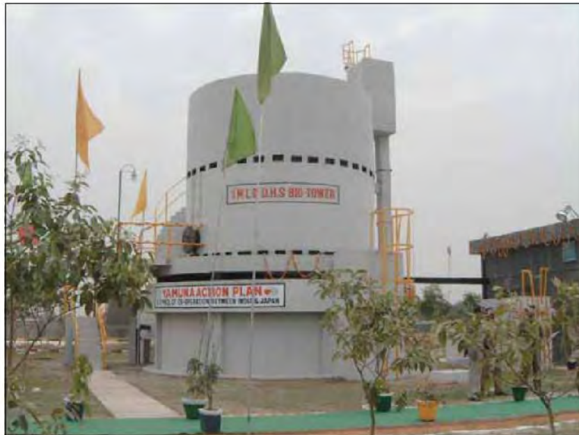
Figura 1.2: El Sistema de Tratamiento DHS de Aguas Residuales en la ciudad de Karnal, India.
