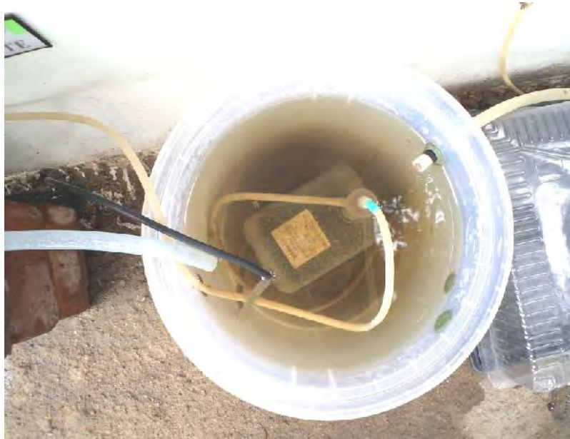
Figura 5.9: Unidad de Recirculación
