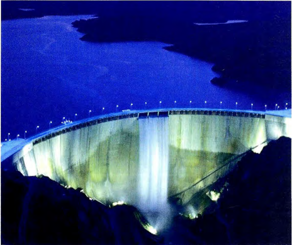
Fig.2.3 Represa tipo bóveda de Altazar - España
