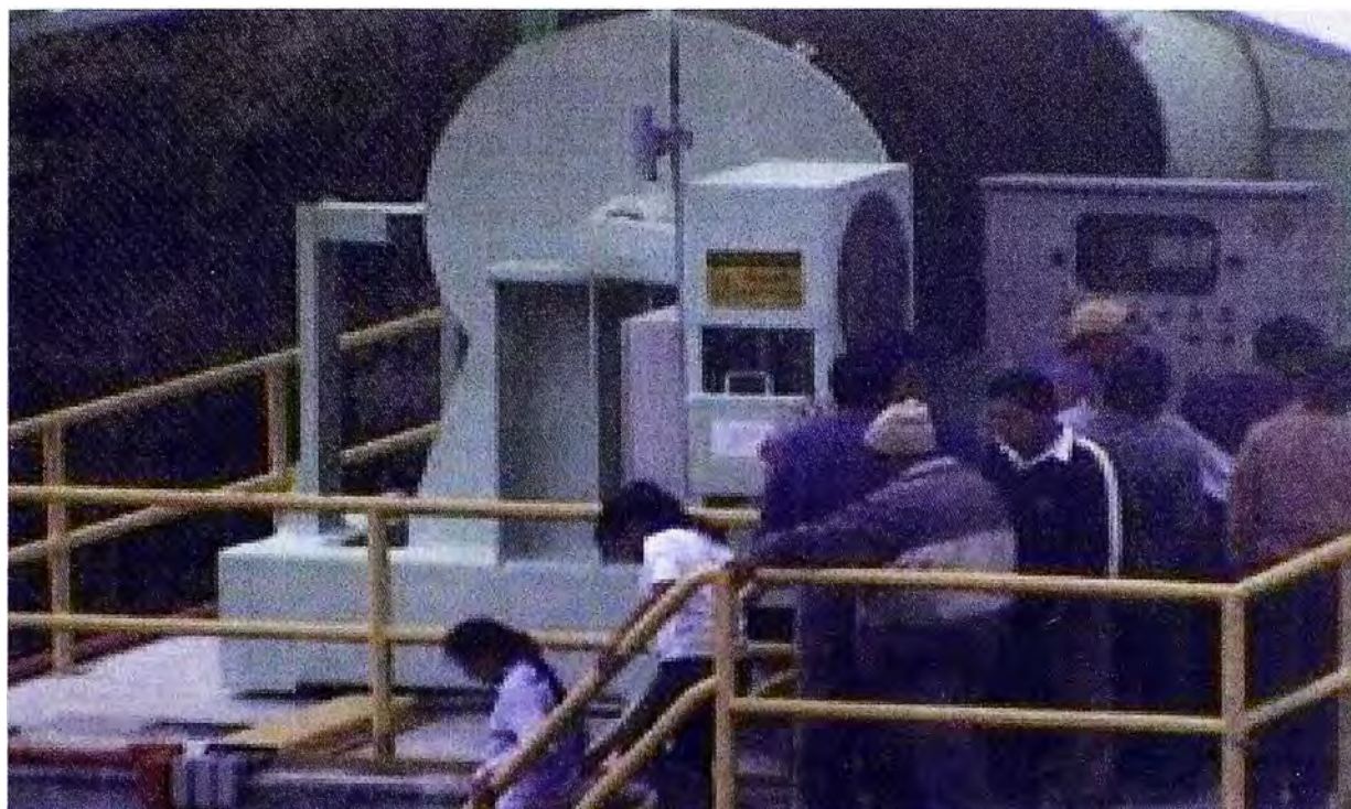
Fig. 3.1 Toma de represa Huallamayo Agosto 2009
