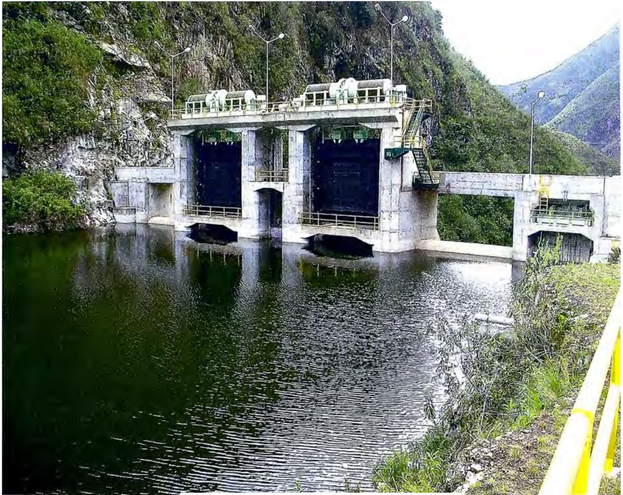
Fig. 2.7. Vista aguas arriba de la represa de Huallamayo
