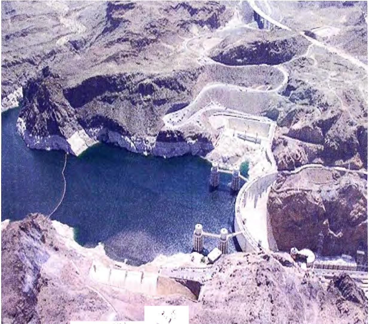
Fig. 2.6. Presa de embalsamiento de Hoover – Arizona
