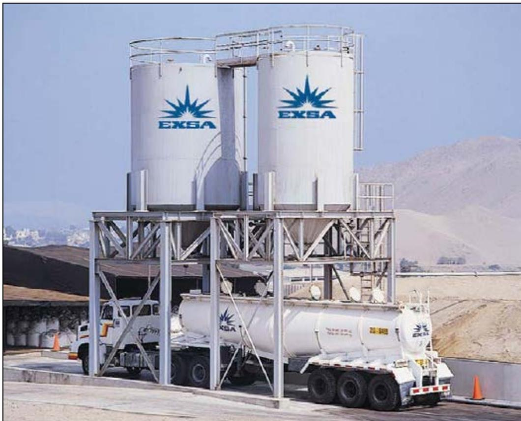
**Figura N° 18. Cami n cisterna de la empresa Exsa S.A. recibiendo de la Planta de Producci n la Emulsi n no explosiva para su transporte hacia la mina.**
