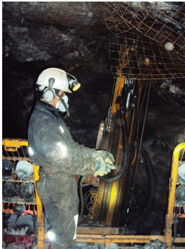
Figura 43 Instalación de elementos mediante el control remoto
