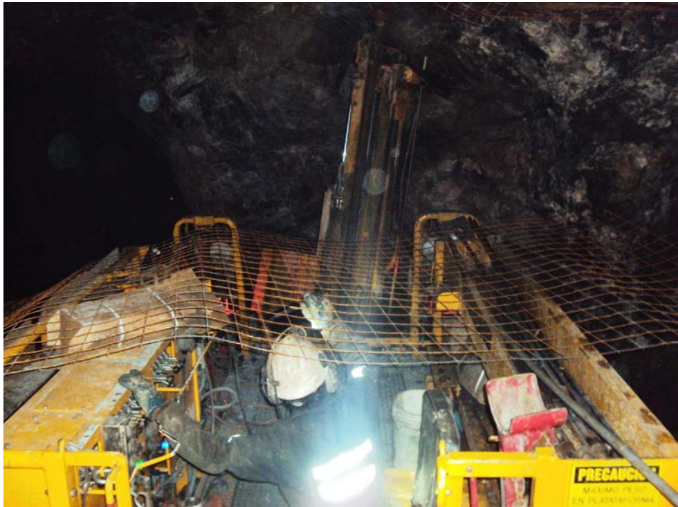
Figura 45 Instalación de malla con scissor Bolter
