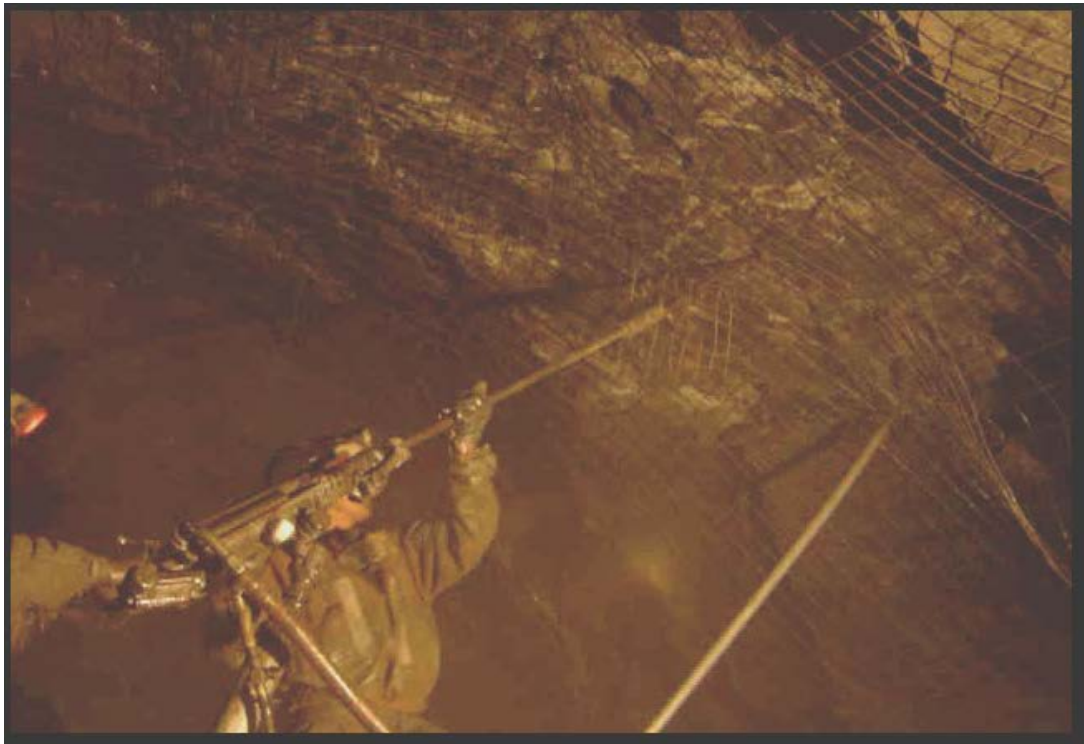
Figura 49 Sostenimiento convencional
