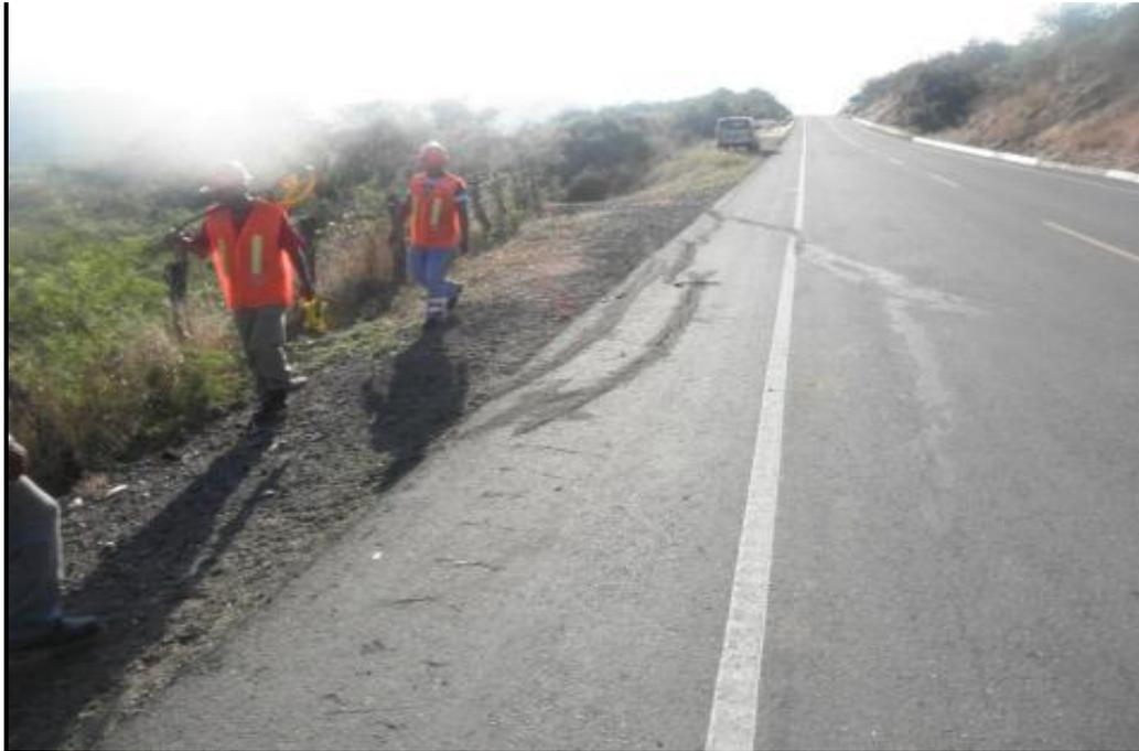
Figura 5.8: Vista de la grieta en forma semicircular de la plataforma de la vía.
