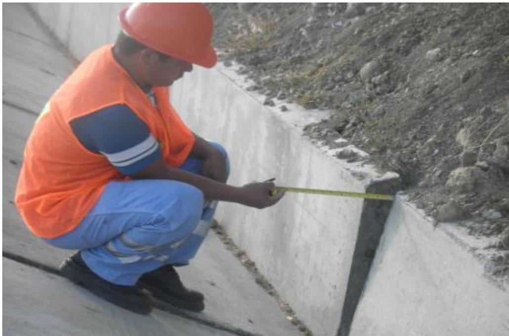
Figura 5.9: Vista de las cunetas afectadas por el empuje lateral del talud superior.
