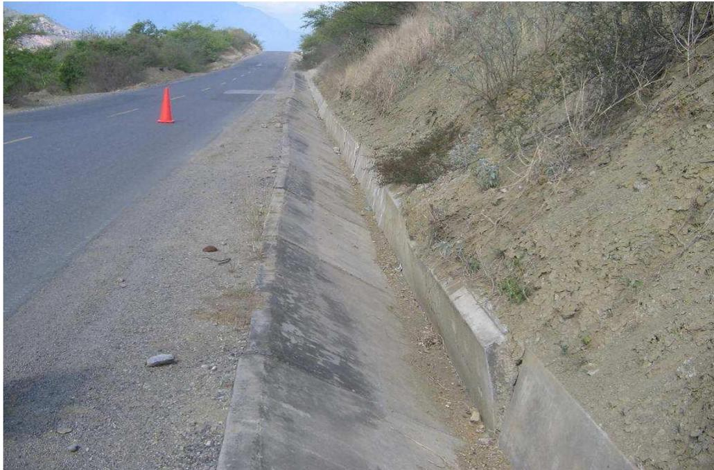
**Figura 5.5: Empuje lateral de talud hacia la vía, reparado mediante ITM que no dio solución al problema.**
