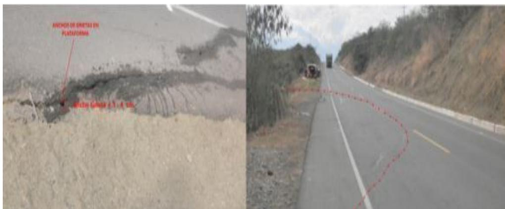
**Figura 5.2: Vista general donde se observa la dimensión de la grieta de tracción en superficie, sellado con ITM que no dio solución al problema.**
