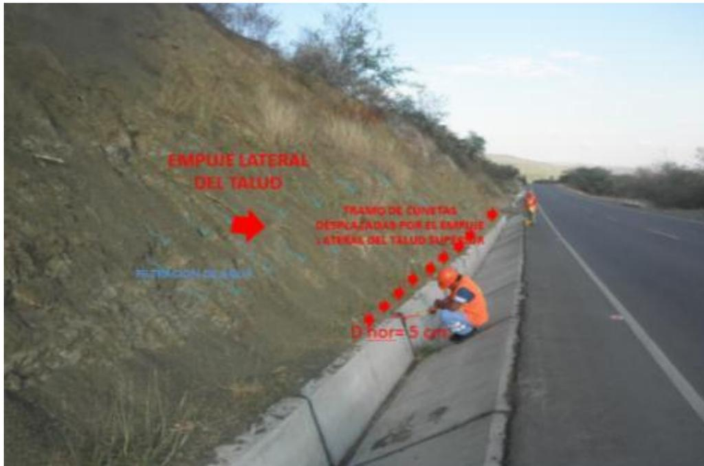
**Figura 5.3: Vista panorámica donde se observa la deformación en la plataforma y el hundimiento que se produce en superficie de la vía.**
