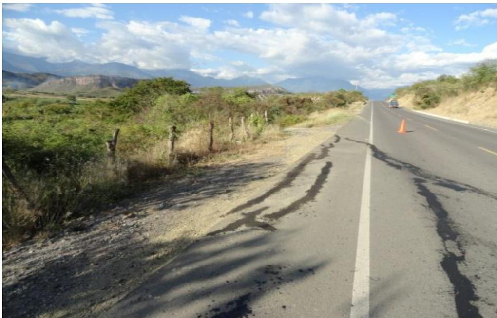
**Figura 4.7: Formación de falla en media luna, en la vía.**
