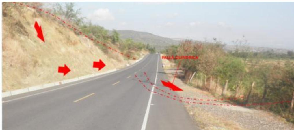
**Figura 5.1: Vista general de la zona, donde se aprecia la forma del deslizamiento.**
