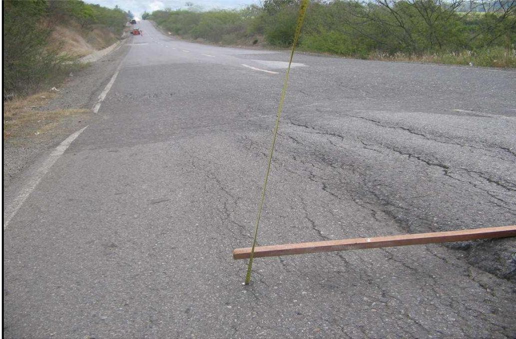
**Figura 5.4: Desplazamiento vertical de 10 cm, reparado mediante ITM.**
