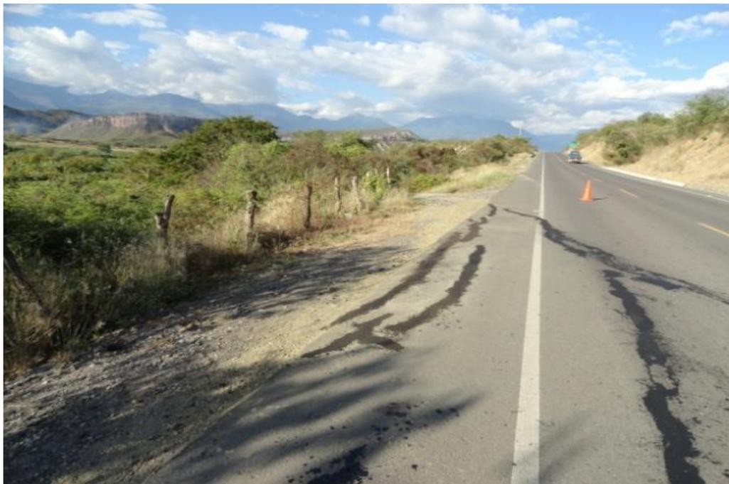
**Figura 5.7: Aparición de fisuras como consecuencia del fenómeno natural que altera el sector.**
