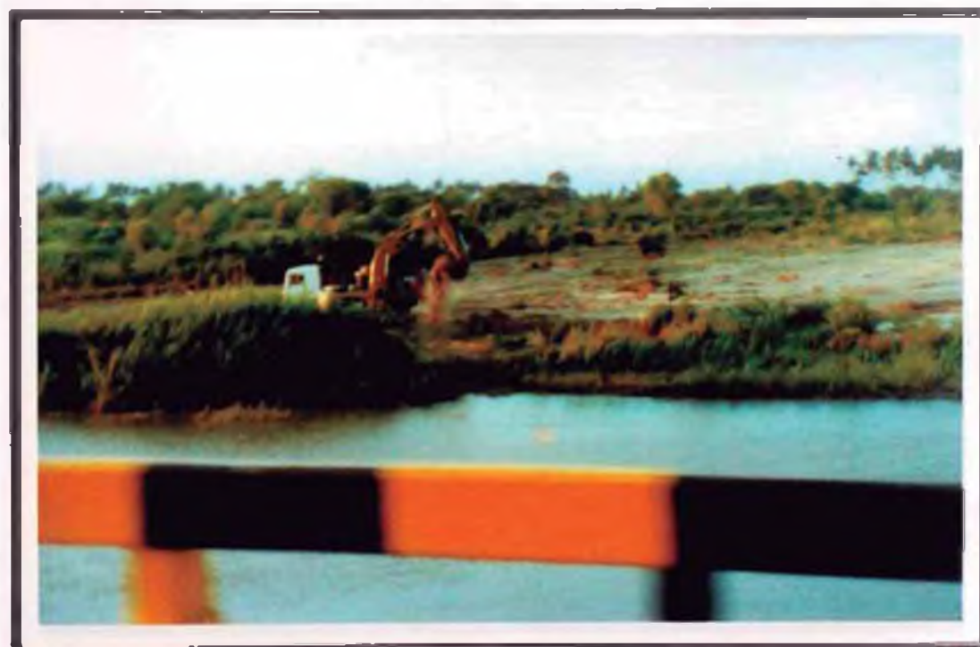
Foto N° 08: Vista Panorámica de las obras de prevención (Encauzamiento) del Río Motupe Viejo. Se realizan las el mantenimiento de estas, previniendo las crecidas de los ríos.
