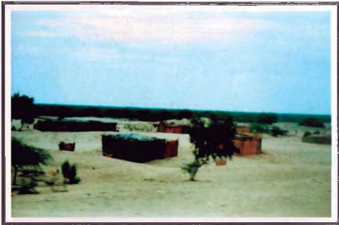
Foto N° 11: Asentamientos improvisados que se ubican a lo largo de la carretera Panamericana Lambayeque Piura. El material de construcción de las viviendas es de carrizo y esteras. En su mayoría no cuentan con servicios básicos.
