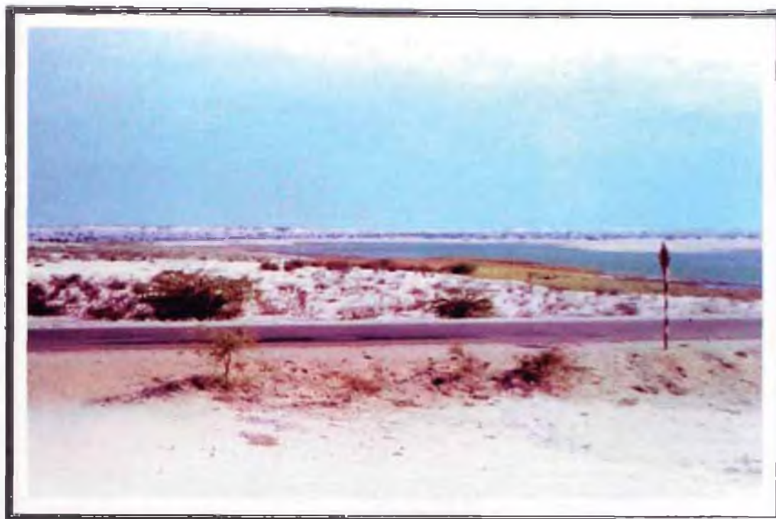
Foto N° 05: Vista Panorámica del Emplazamiento de la Laguna La Niña, se observa que afecto parte de la carretera.
