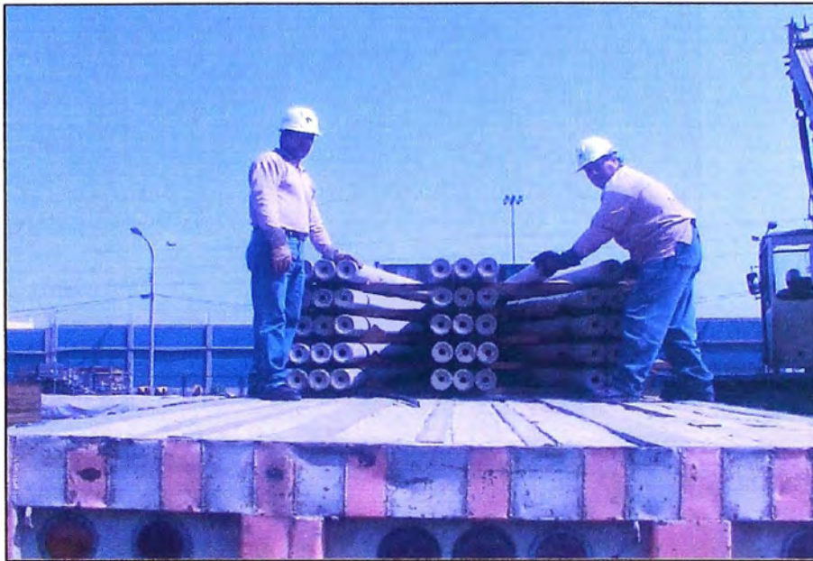
Fig. 4.9: Colocación de estrobos
