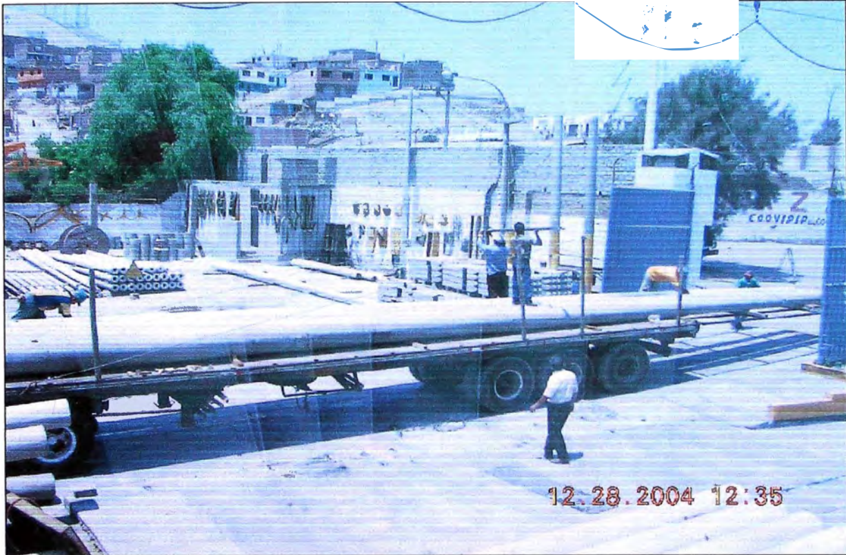
Fig. 4.19: Transporte de postes de 18m a obra 1
