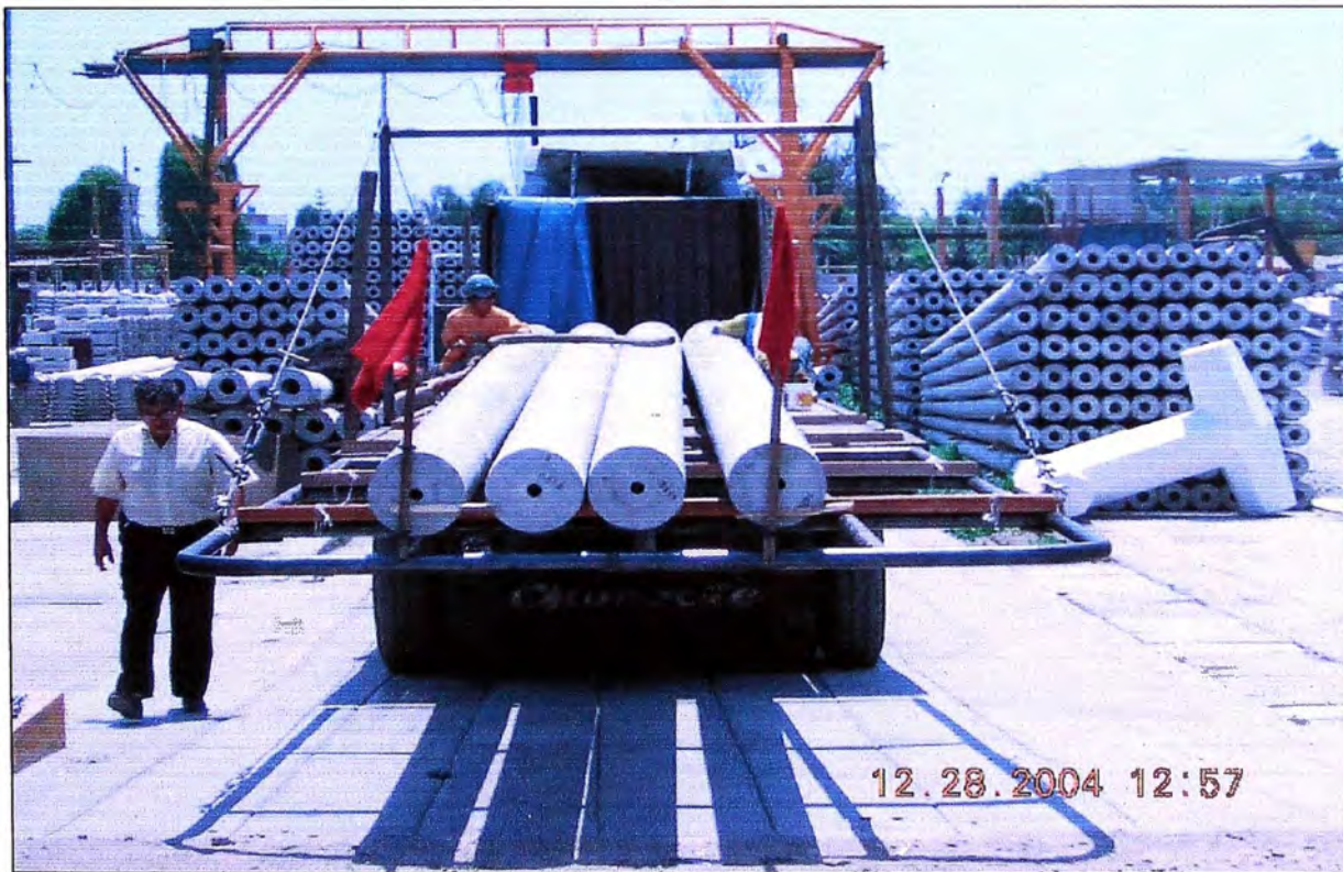
Fig. 4.20: Transporte de postes de 18m a obra 2
