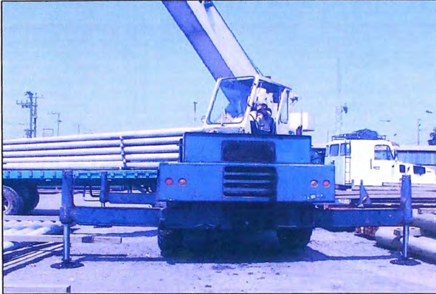
Fig. 4.7: Inspección de Grúa
