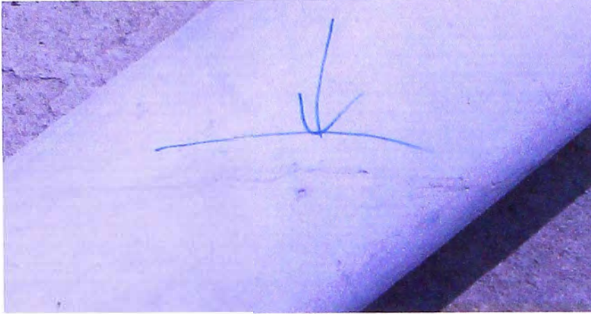
Fig. 3.2 Resultado de la Prueba de Rotura
