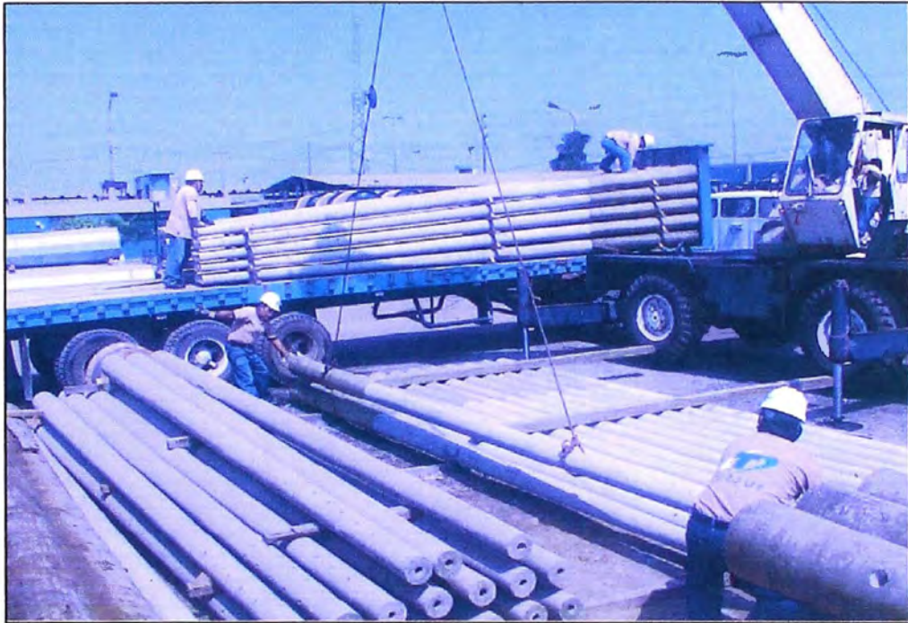
Fig.4.12: Termino de trabajo.
