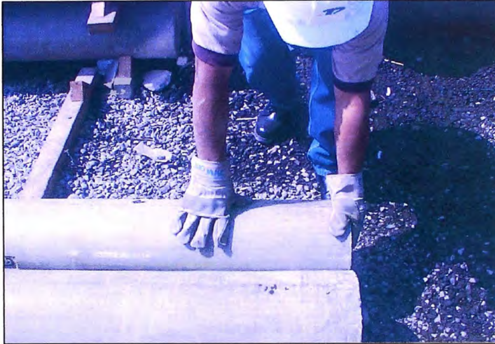
Fig. 4.11: Posicionamiento de postes.
