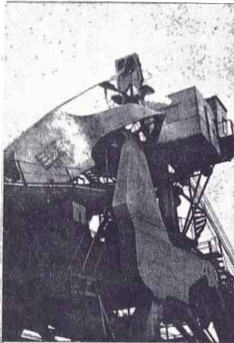
Fig. 3.9. Tokachi-Oki. Alimentador de minerales. El brazo que sostenía el contrapeso se rompió.
