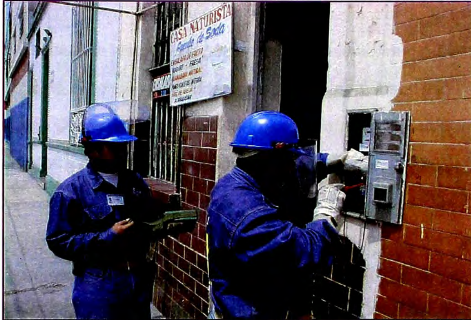
Fig. 5.6: Equipo Registrador Monofásico de Baja tensión Instalado en una Caja Portamedidor
