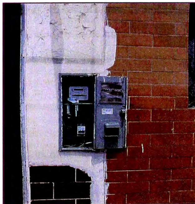
Fig. 5.6: Equipo Registrador Monofásico de Baja tensión Instalado en una Caja Portamedidor
