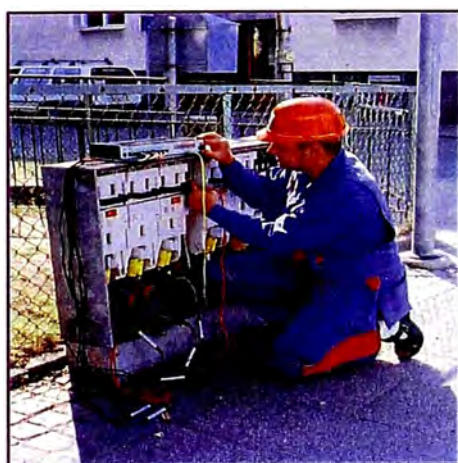
Fig. 5.7: Instalación de un Equipo Registrador en el lado de Baja Tensión de una Subestación de Distribución
