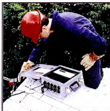
Fig. 5.7: Instalación de un Equipo Registrador en el lado de Baja Tensión de una Subestación de Distribución
