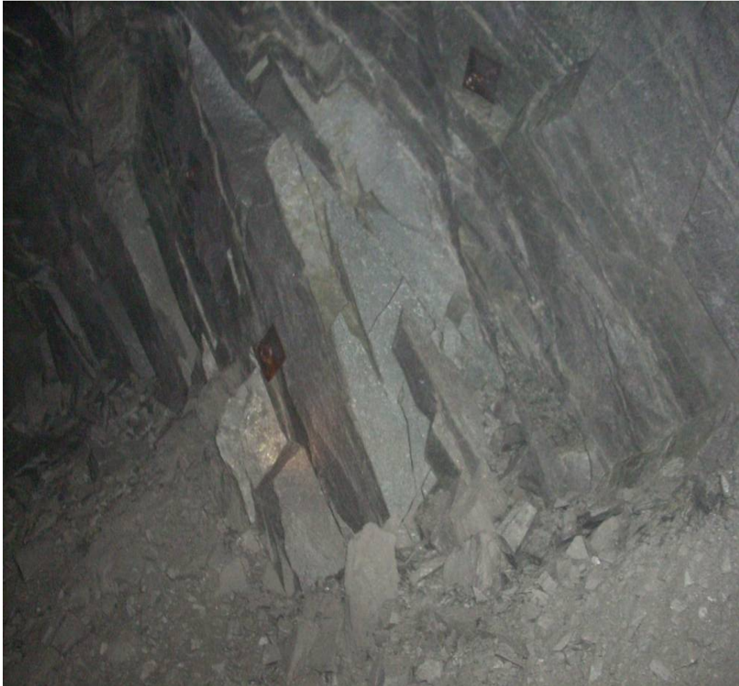
FIGURA 22 GALERÍA ESPERANZA SIN SOSTENIMIENTO
